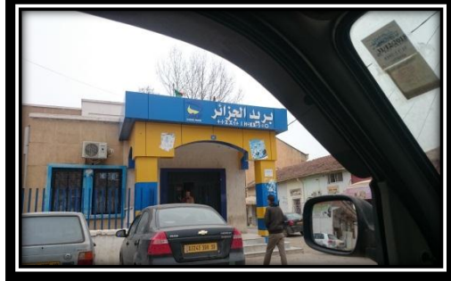
الصورة رقم (13) تجهيز إداري
