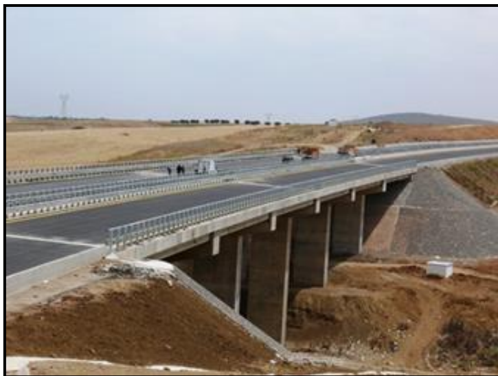
Figure 8 : viaduc dans Tlemcen.
