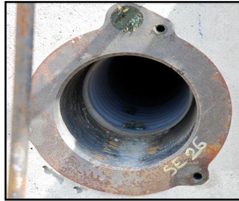
Figure 15 : Une tromplaque après le collage du béton.
