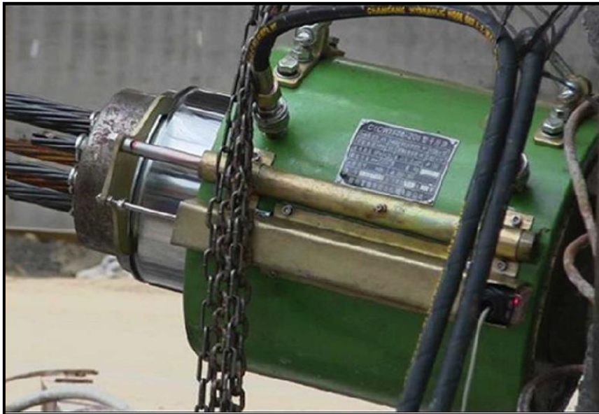
Figure 18 : Le vérin de mise en tension.
