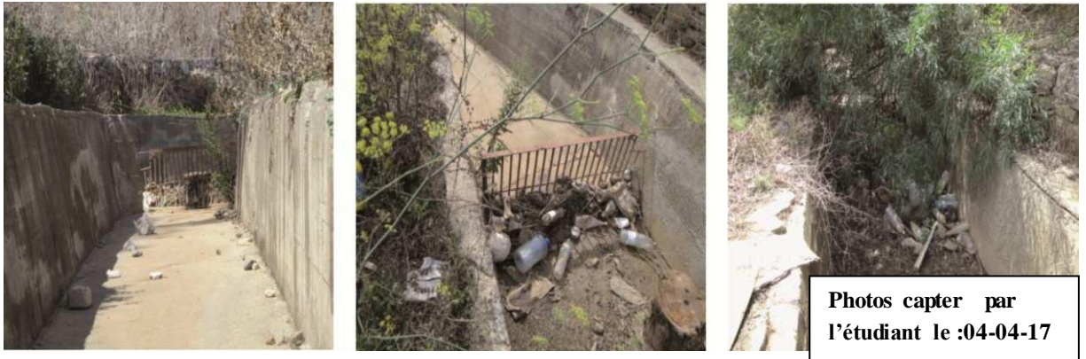
Fig. 5.4. Canal à ciel ouvert situé en amont de l'ouvrage hydraulique de réception.
