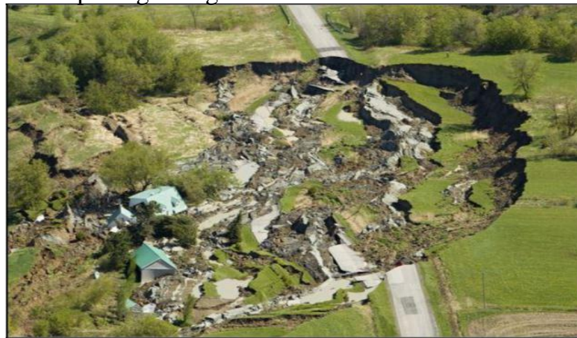
Fig1. 08 : Glissement du terrain au Québec Source : David Boily, 2010 , consulté le 10/03/2017
