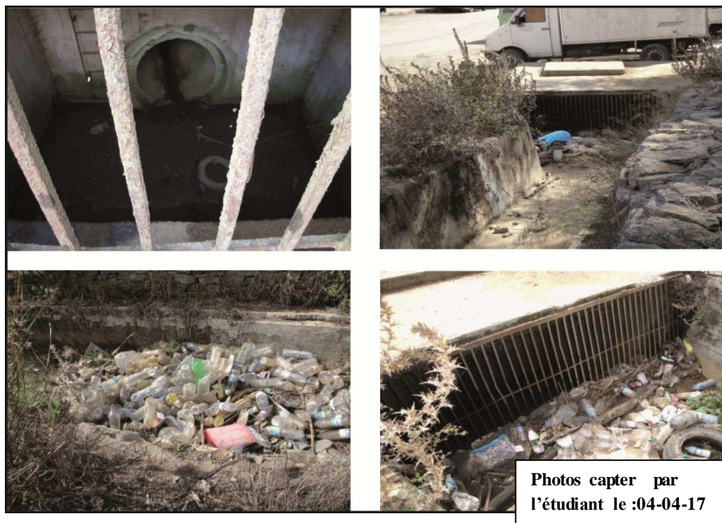
Fig. 5.3. Etat de l'ouvrage Baranes.
