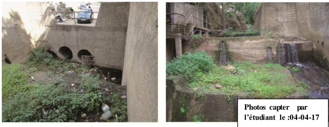
Fig.5.11. Ouvrage hydraulique Chemin du Fort.
