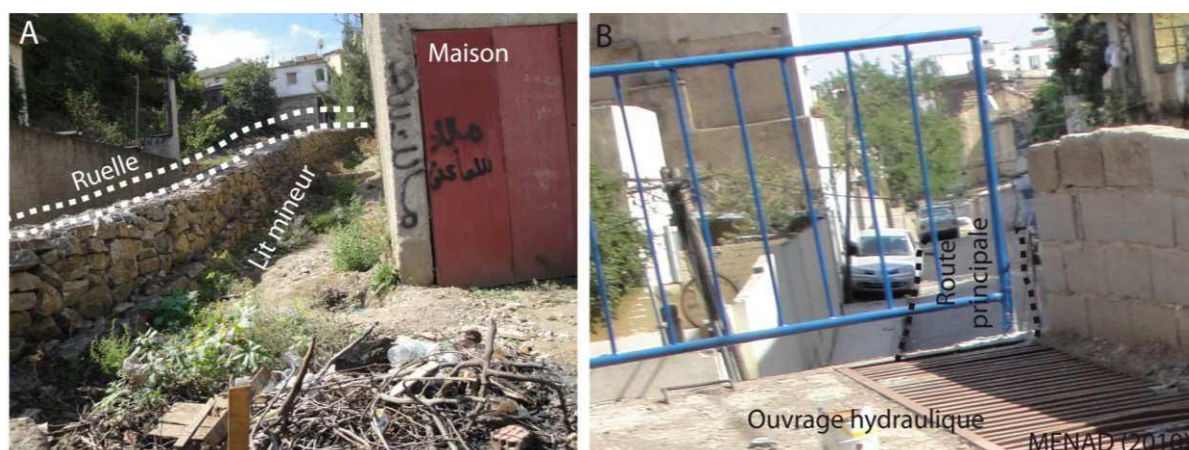
Fig. 5.25. Sous-bassin-versant de Scotto Nadal (A). Entrée amont de l'ouvrage hydraulique (B). Paysage en aval de l'ouvrage.
