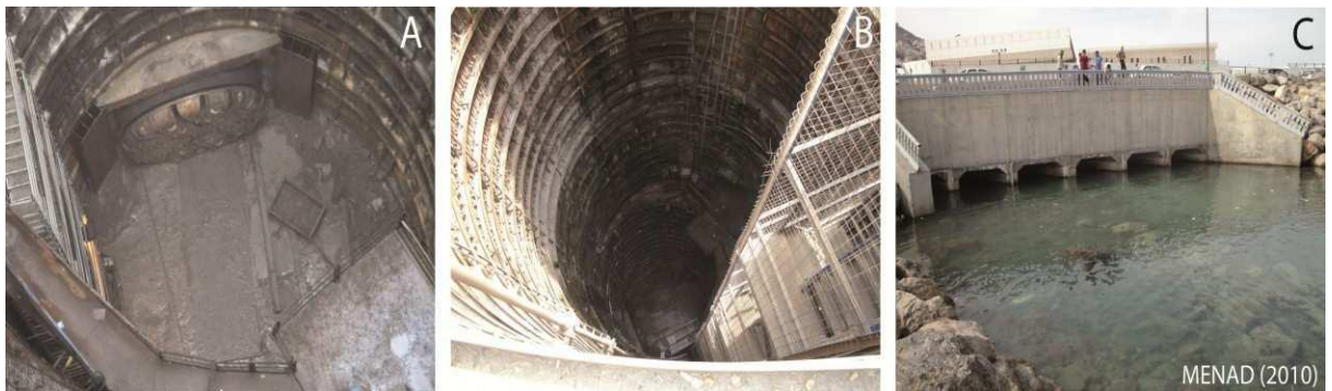
Fig. 5.15. A et B : Puits de raccordement à Frais Vallon ; C : Point de rejet en mer.
