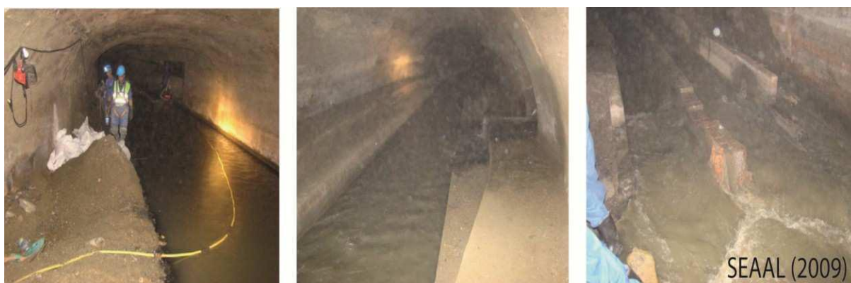
Fig. 5.13. Travaux de curages à l'intérieur du collecteur Oued M'Kacel.
