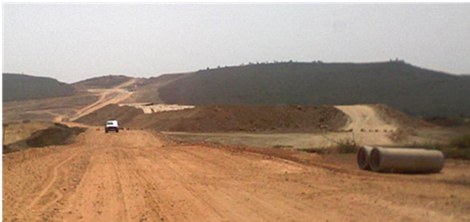
Figure. IV.2 Implantation du remblai
