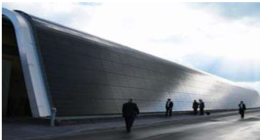
Figure I.7. Façade en CIGS au Pays de Galles, efficacité de 8.5%.
