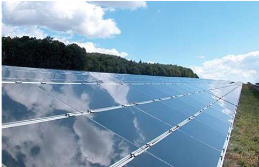
Figure I.6. Modules verre-verre au Telluride de Cadmium, efficacité de 9 à 11%.
