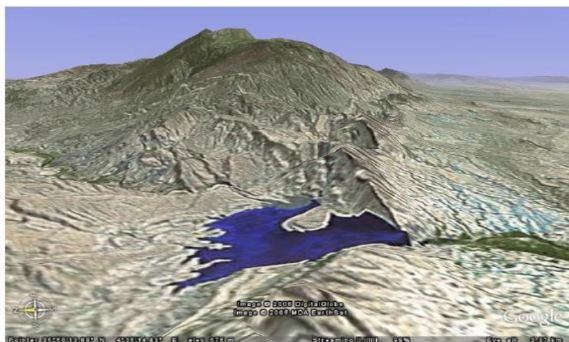
Figure I.5 Vue aérienne du barrage du K'Sob par Google Earth
