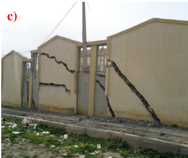
Figure 2.5 Désordres provoqué par la variation volumique du sol de fondation site de Sidi-Hadjrès
