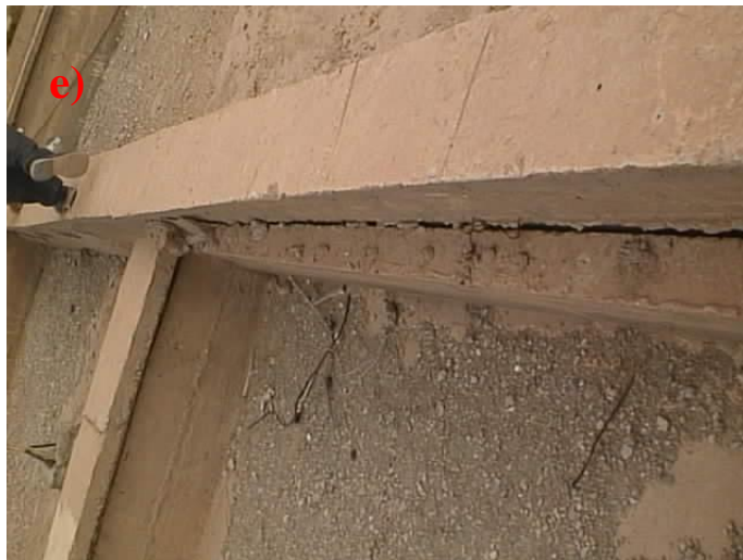
Figure 2.4 Désordres provoqué par la variation volumique du sol de fondation site de Sidi-Aissa a), b) et c) fissuration dans les murs en maçonnerie, d) soulèvement et rupture du carrelage, e) ouverture du joint de dilatation, f) détachement de mur
