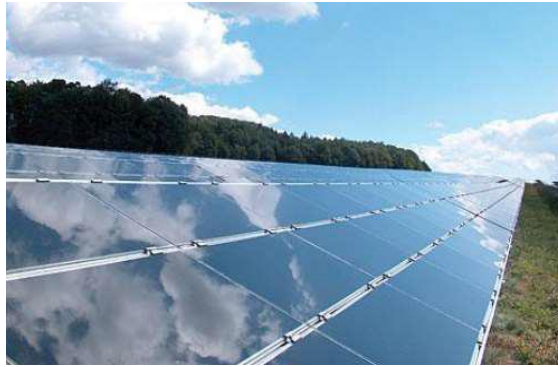
Fig I.10 Modules verre-verre au Telluride de Cadmium, efficacité de 9 à 11%.
