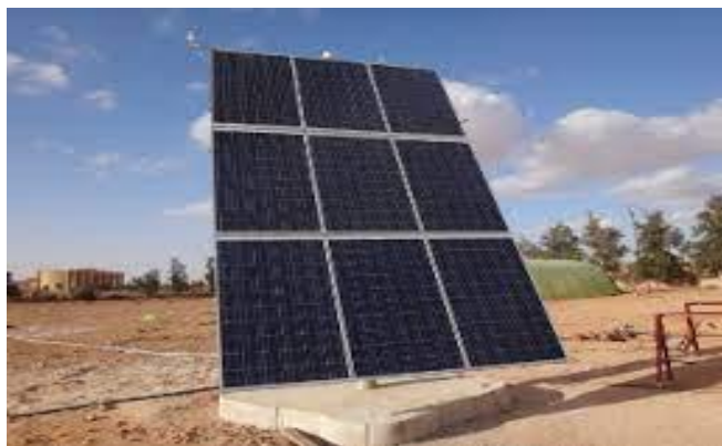
Fig.17 la cellule photovoltaïque Contée du réseau.
