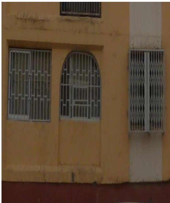
Barreaudage métallique pour fenêtre et balcon.
