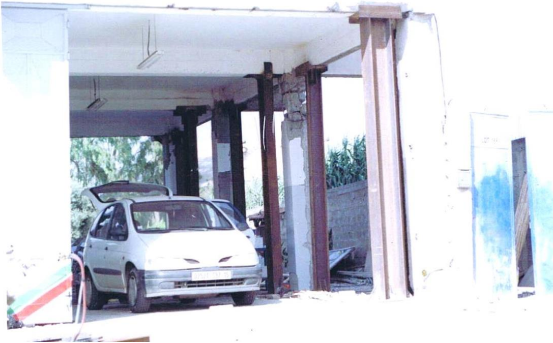
Figure 5-9 : RDC vulnérable renforcé par colonnes métalliques
