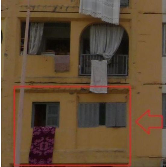
Pose de persienne et fermeture du balcon en dur.
