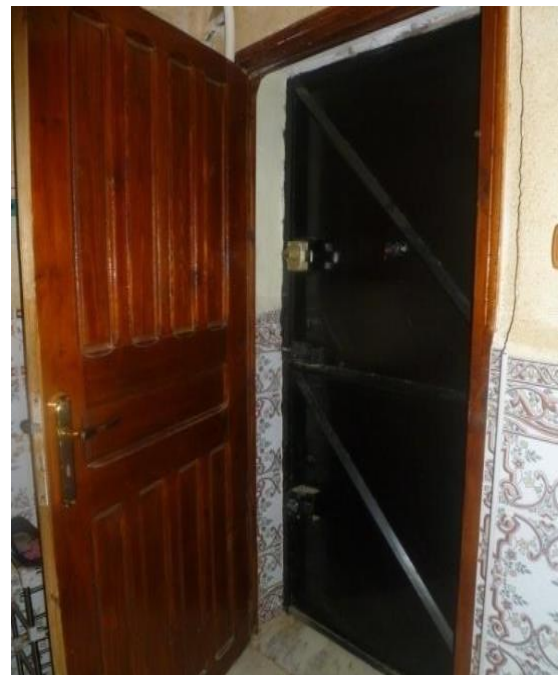
Porte de renforcement métallique avec porte préexistante en bois.
