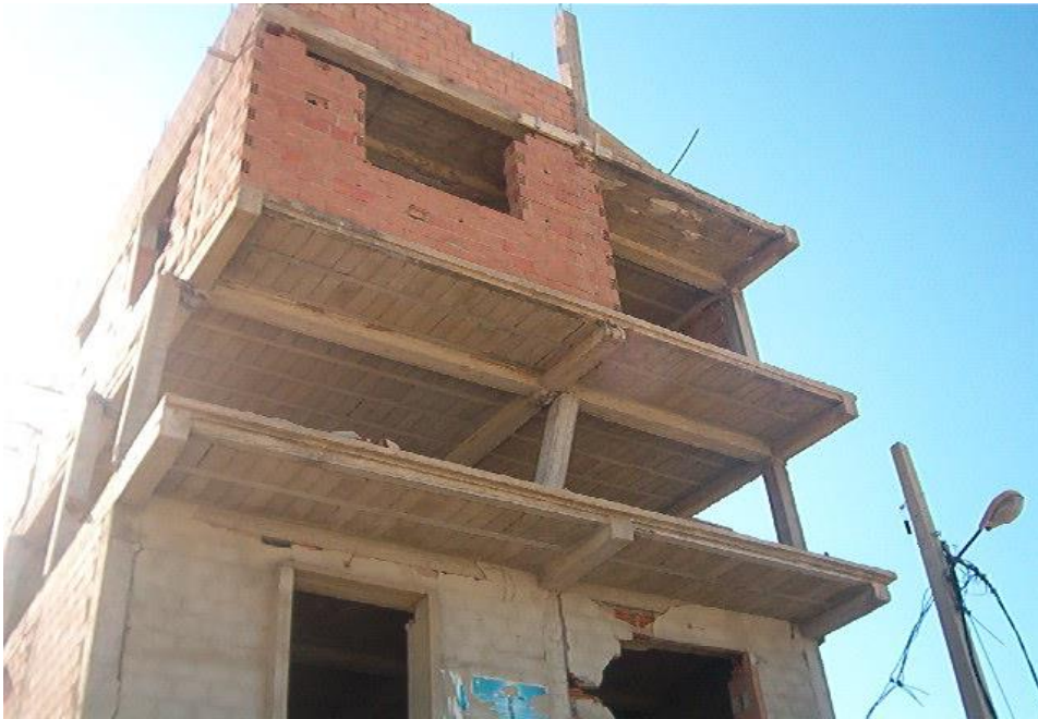
Figure 5-3 : la vulnérabilité est cette fois ci observée au niveau du 1 er étage
