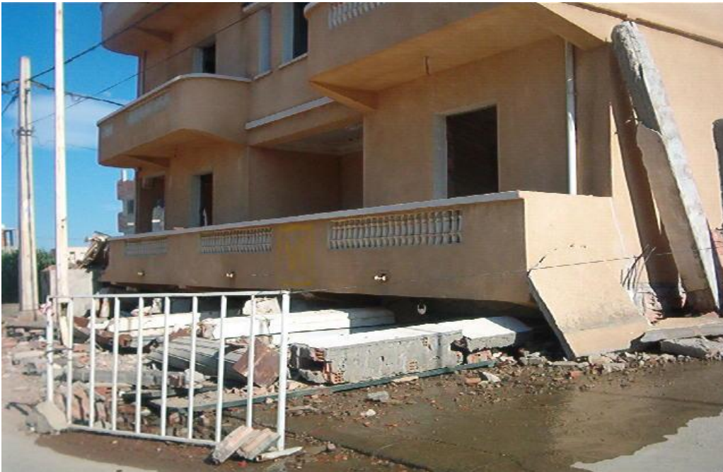
Figure 5-3 : la vulnérabilité est cette fois ci observée au niveau du 1 er étage
