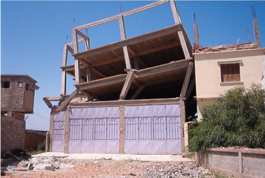
Figure 5-1 : Les étages supérieurs au RDC sont complètement ruinés car relativement très vulnérables
