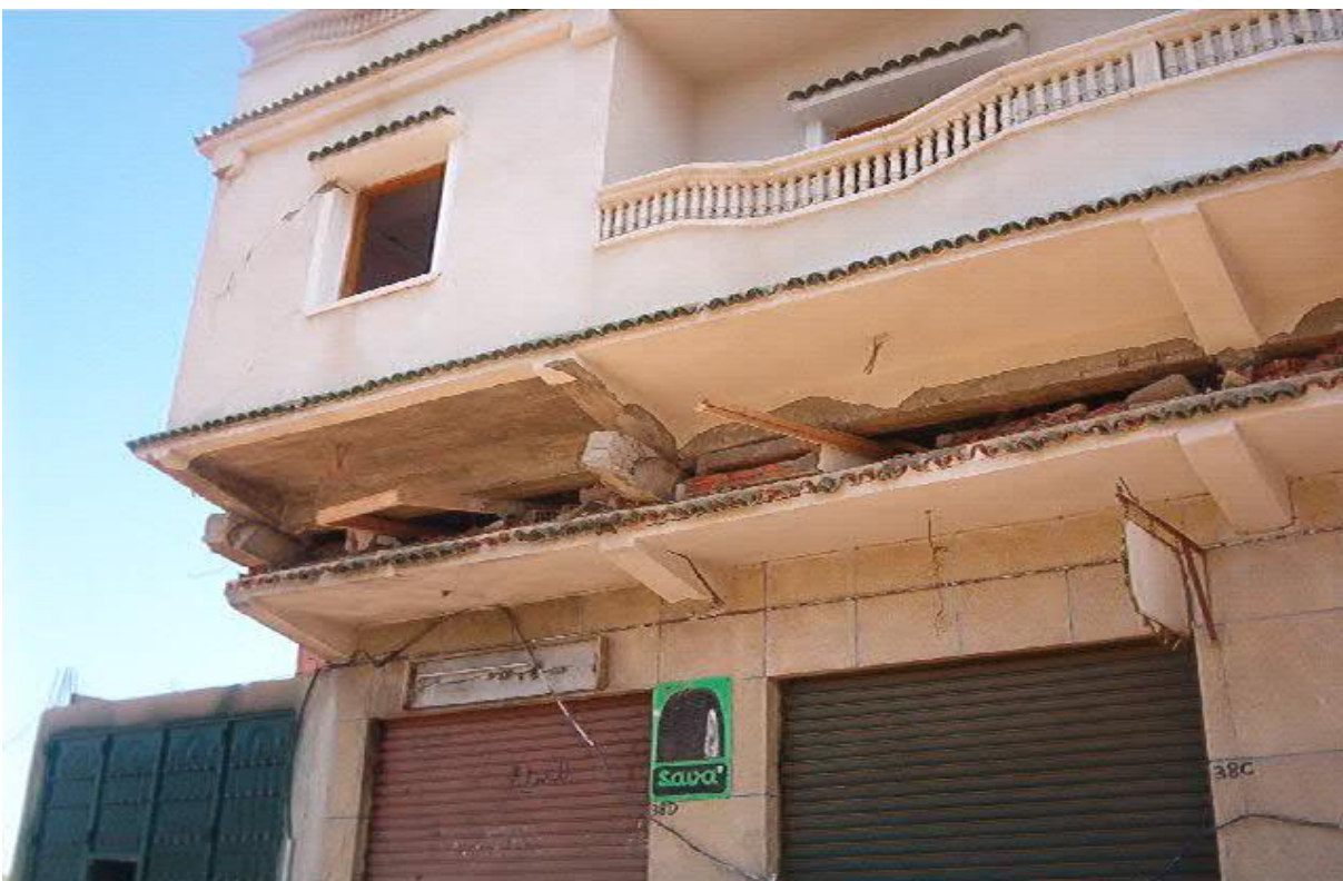
Figure 5-1 : Les étages supérieurs au RDC sont complètement ruinés car relativement très vulnérables
