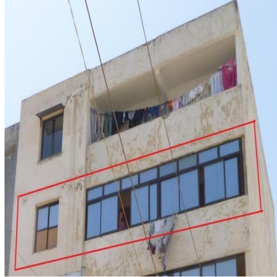
Pose de véranda en verre translucide.
