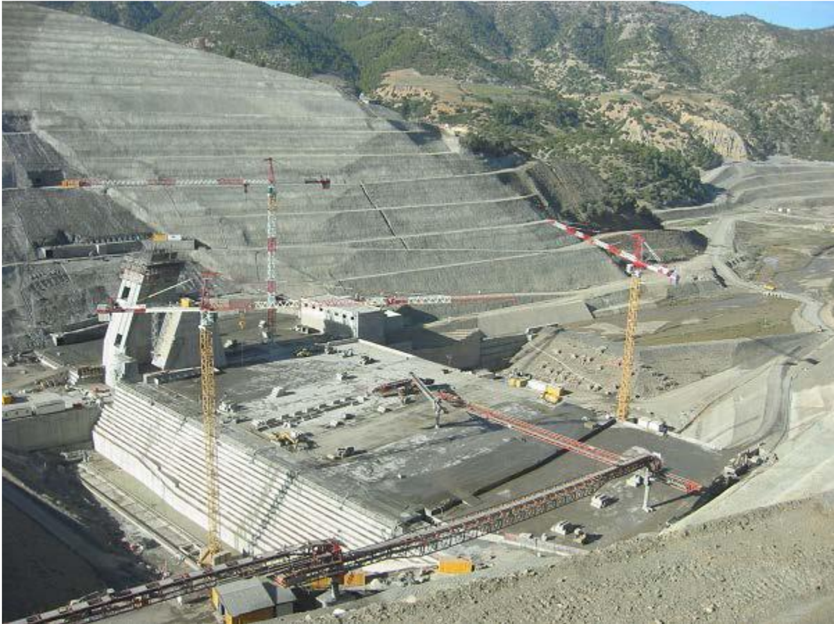
Figure I. 4 : Barrage de Koudiat-Acerdoune en Algérie, pendant la construction (Forbes 2007).
