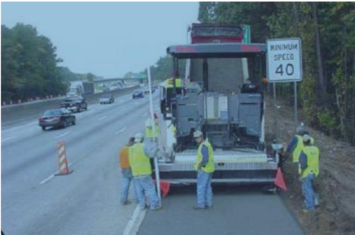
Figure I. 6 : Mise en place du BCR en pavage - Atlanta USA (ZDIRI M 2008).
