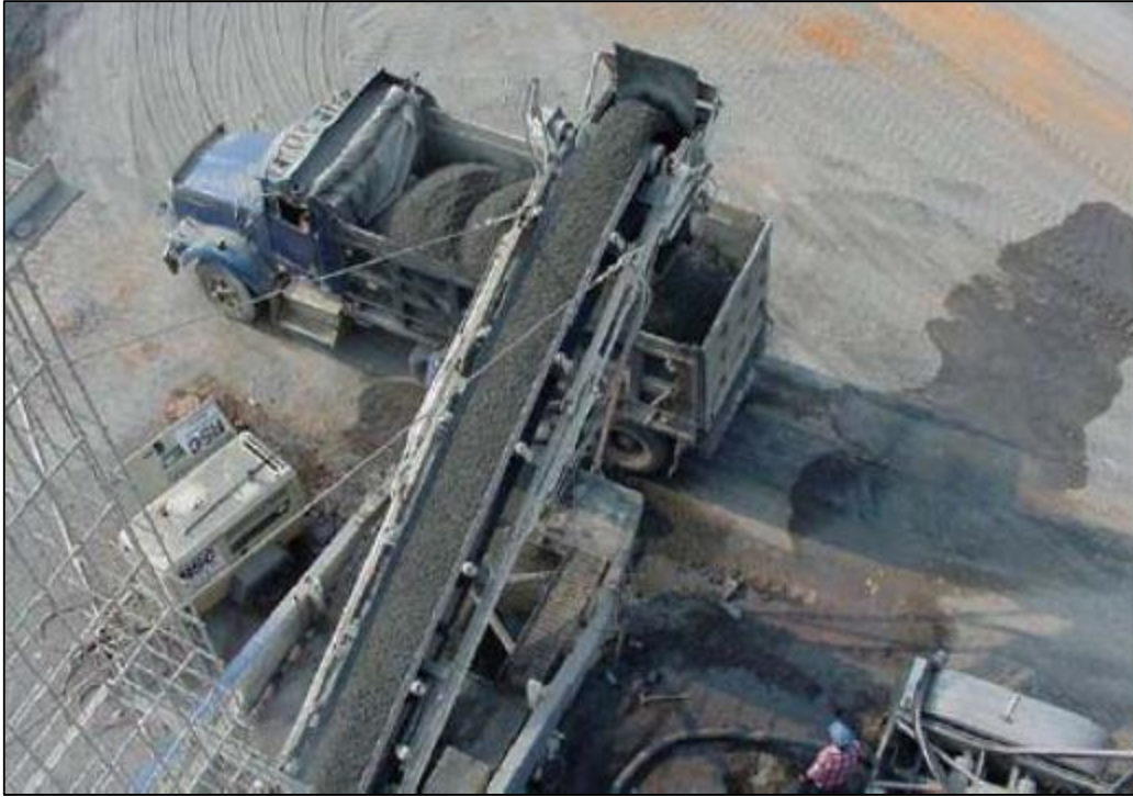
Figure I. 12 : Dosage, malaxage et transport du BCR (ZDIRI M 2008).
