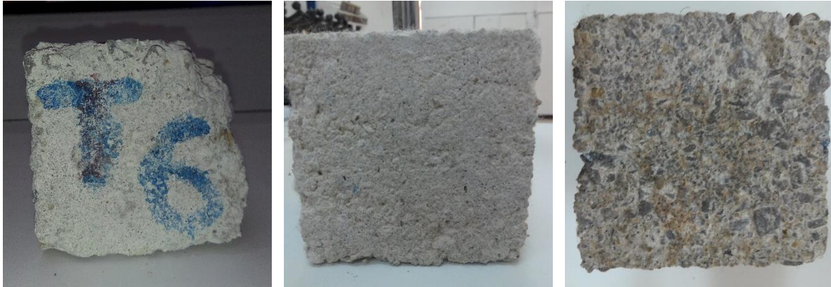
Figure V. 34 : Les observations visuelles des dégradations.
