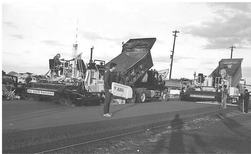
Figure I. 2 : Mise en place d'un BCR routier (ACI Comitee 2001).
