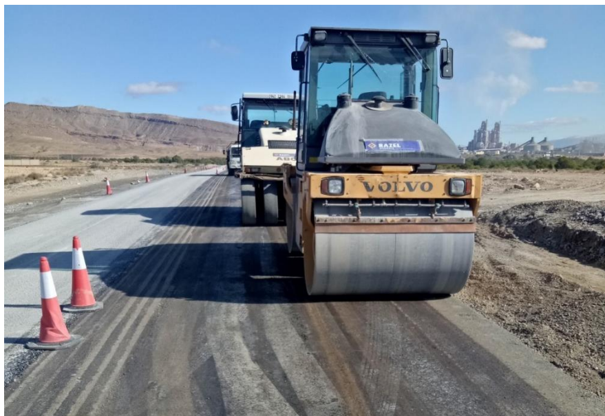
Figure I. 3 : Mise en place d'un BCR routier (route HAMMAM DALAA).
