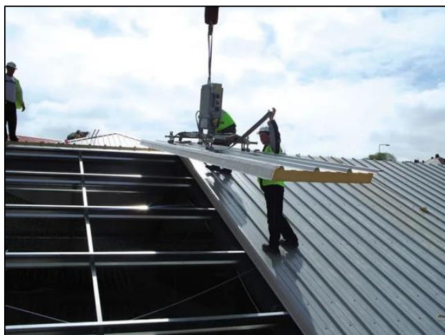
photo 3.1- La pose des panneaux sandwichs.
