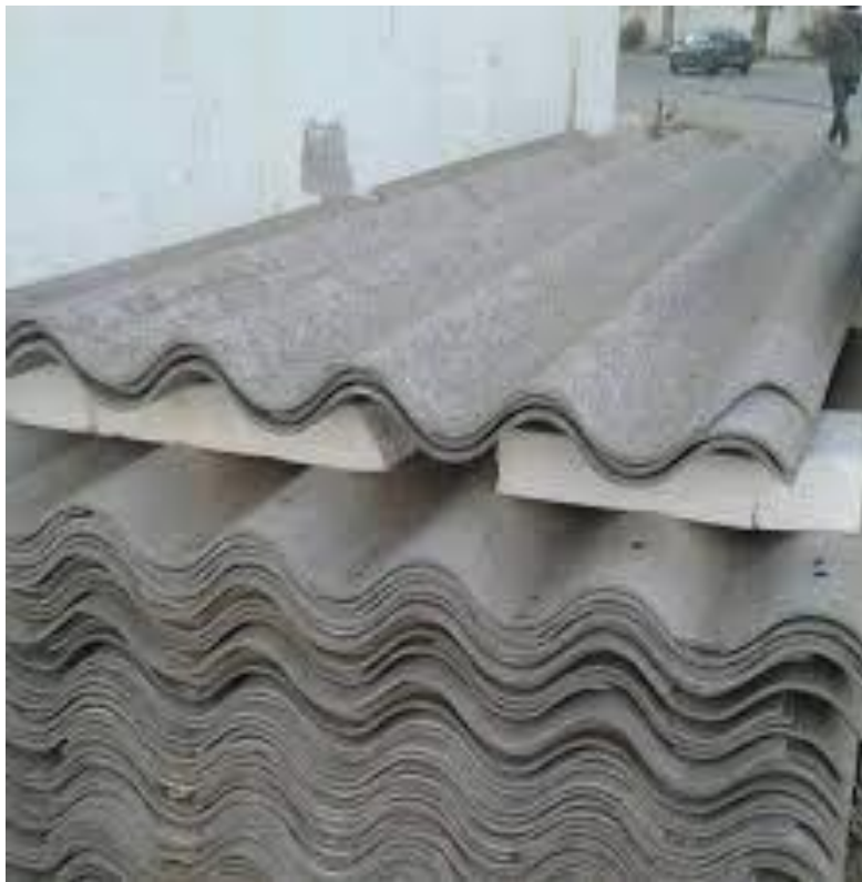
Photo 2.16- Les plaques ondulées en fibrocement
