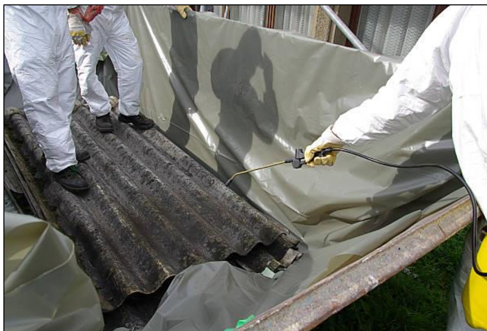
Photo 2.17-Pulvériser du PVA sur le panneau d'amiante.
