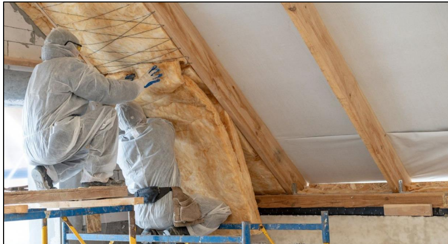
Photo 3.3- Installation d'isolation acoustique.
