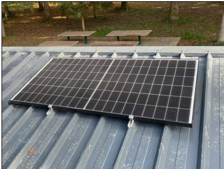
Photo 2.13- l'installation de panneaux photovoltaïques.
