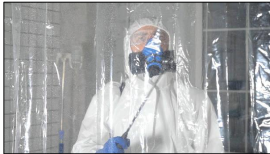
Photo 2.3- La mise en place des bâches en plastique.
