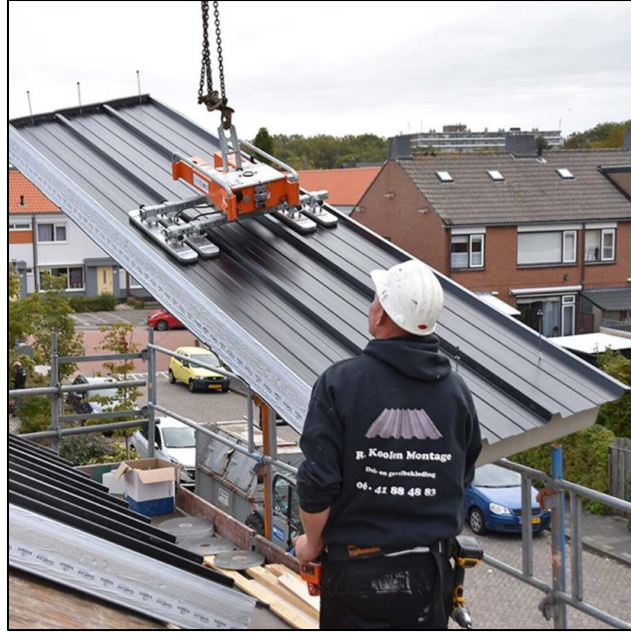
Photo 3.4- préparation des plaques métalliques.
