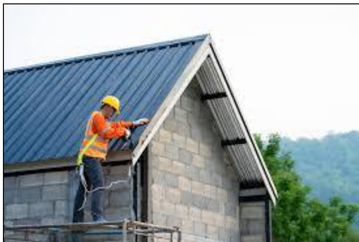
Photo 2.14- Installation de panneaux sandwich.
