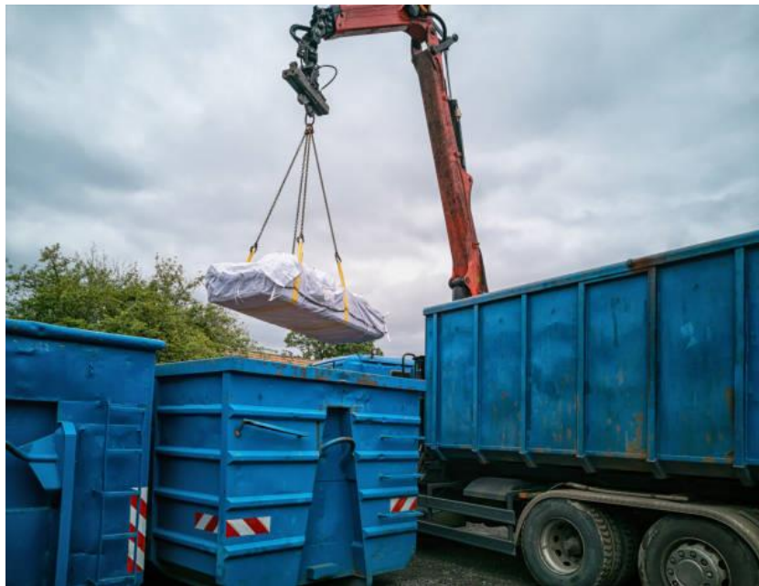
Photo 2.8- conteneurs de stockage des plaques d'amiante.
