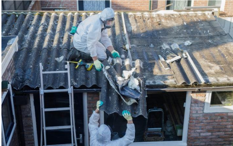
Photo 2.18- Désamiantage manuel sur de courtes distances.
