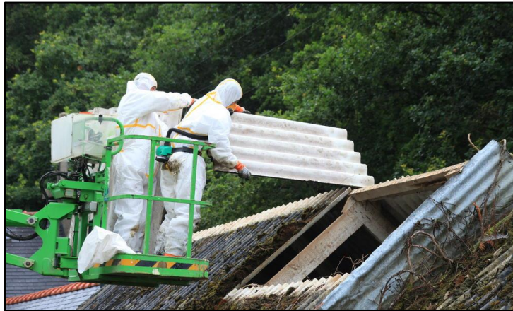
Photo 2.6- Le retrait des plaques d'amiante-ciment.
