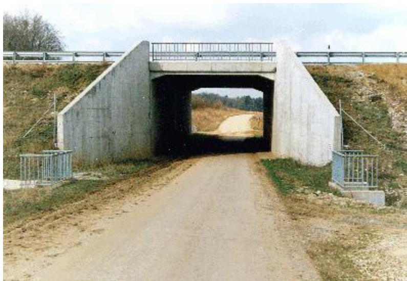
Figure( 1-1) : Schéma type d'un PICF.
