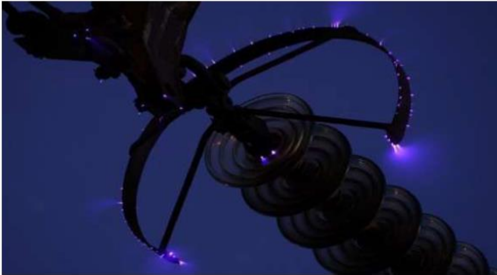
Figure III.6. Effet de couronne sur un éclateur
