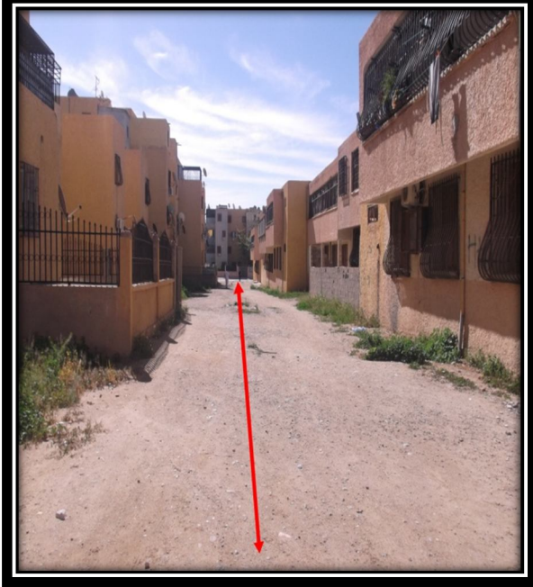
الصورة رقم 26: ممر غير مهياً من الجهة الشمالية
