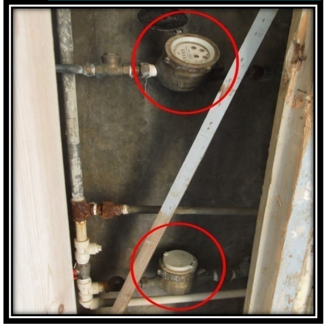
الصورة رقم 32: عداد الماء الصالح للشرب
