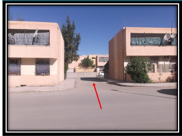
الصورة رقم 2: منفذ للحركة الميكانيكية من الجهة الجنوبية
