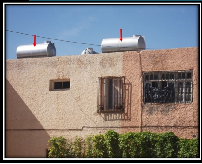
الصورة رقم 40: وضع خزانات الماء على السطح
