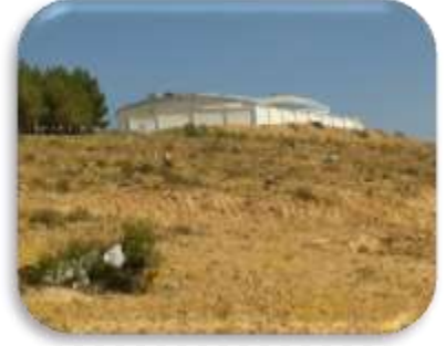
صورة 04 : منحدرات تحتوي على خزاني مياه
