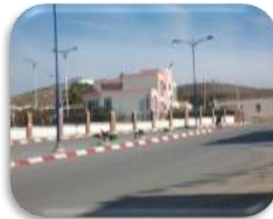
صورة 33 : محطة نقل المسافرين المصدر: من إعداد الطلبة 2014/06/03.
