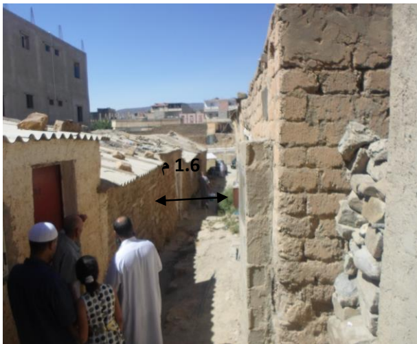
الصورة رقم: (04) تبين البنايات الهشة بالحي القديم بمركز مدينة حمام الضلعة
