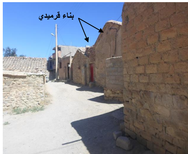
الصورة رقم: (03) تبين البنايات الهشة بالحي القديم بمركز مدينة حمام الضلعة
