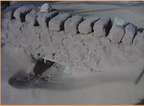
الصورة(62) :حائط الطوب المثقوب المصدر : التقاط الطالب 2015
