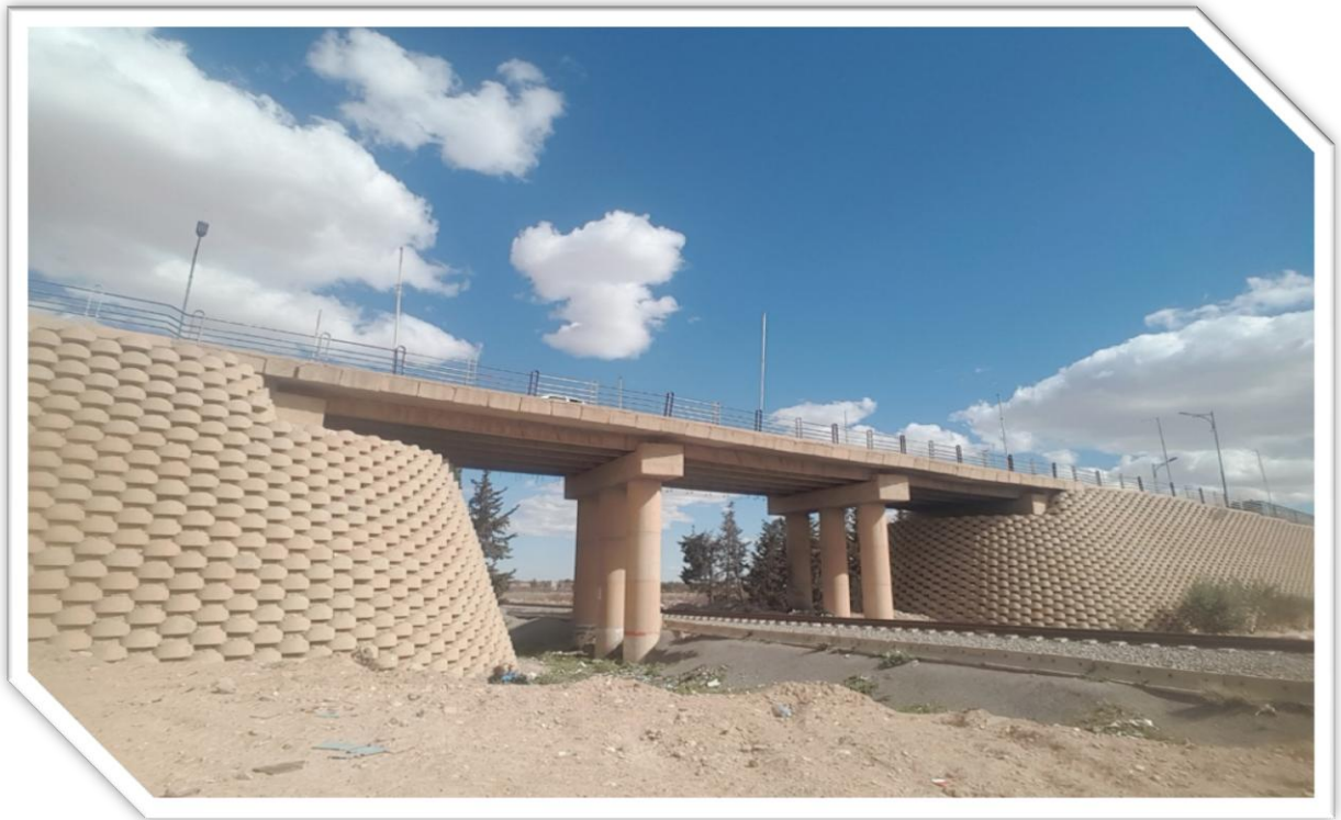
Figure I : Montre une vue de face de l'ouvrage
