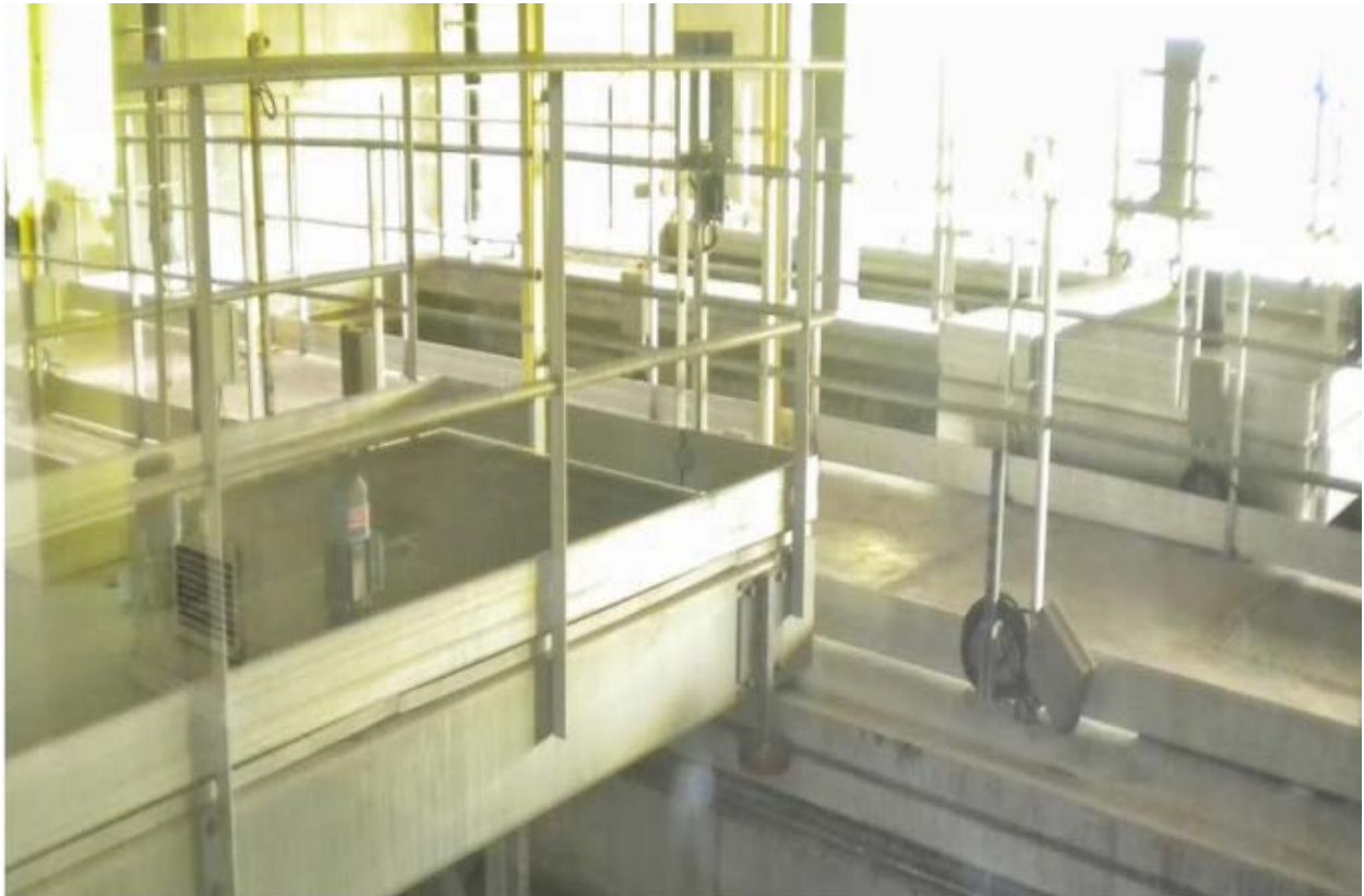
Figure 5: Le processus de dégraissage (Tebib, 2020).
