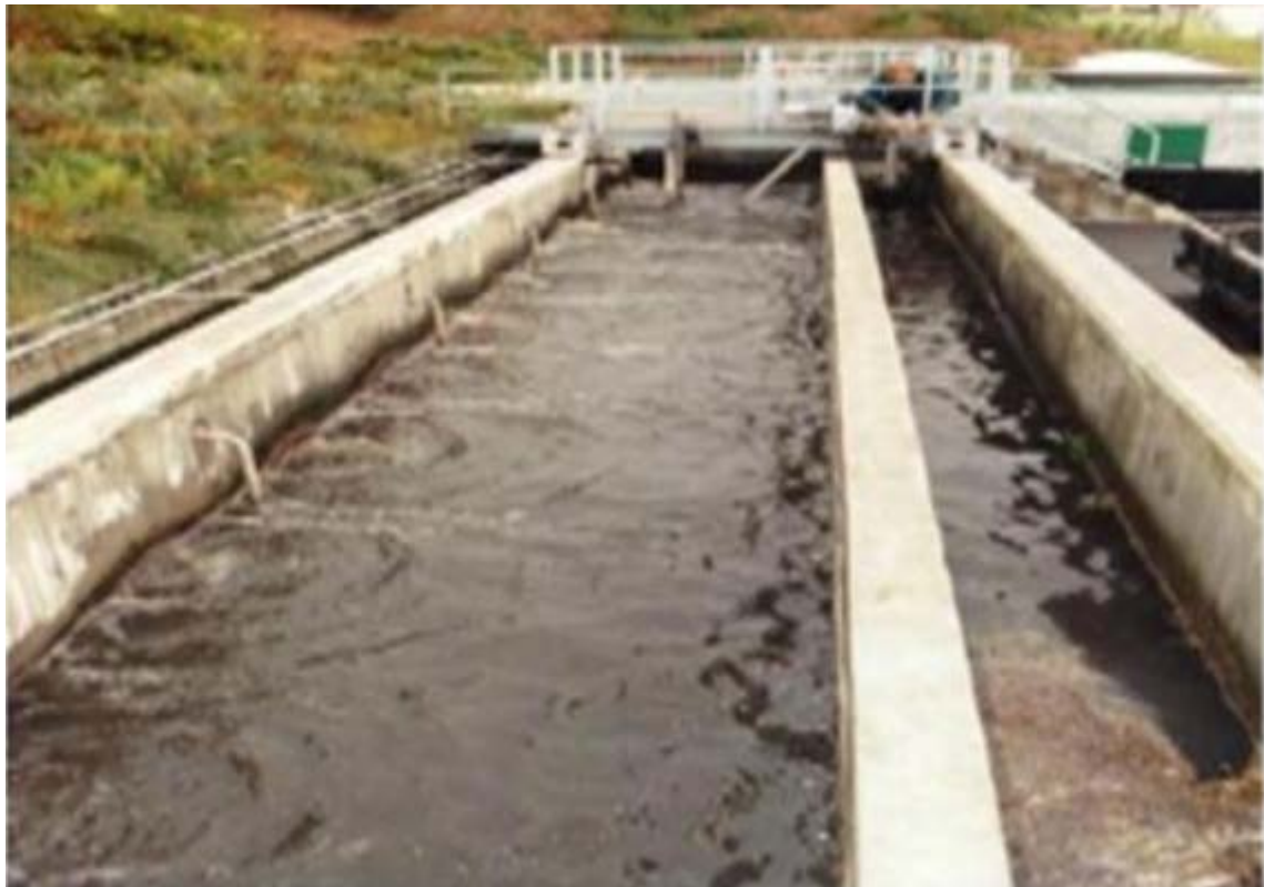
Figure 6: Schéma d'un déssableur (Tebib, 2020).
