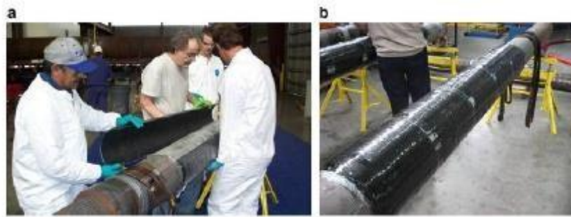
Figure III.22: (a) Installation de la moitié de la coquille du composite en carbone, (b) réparation finale en composite
