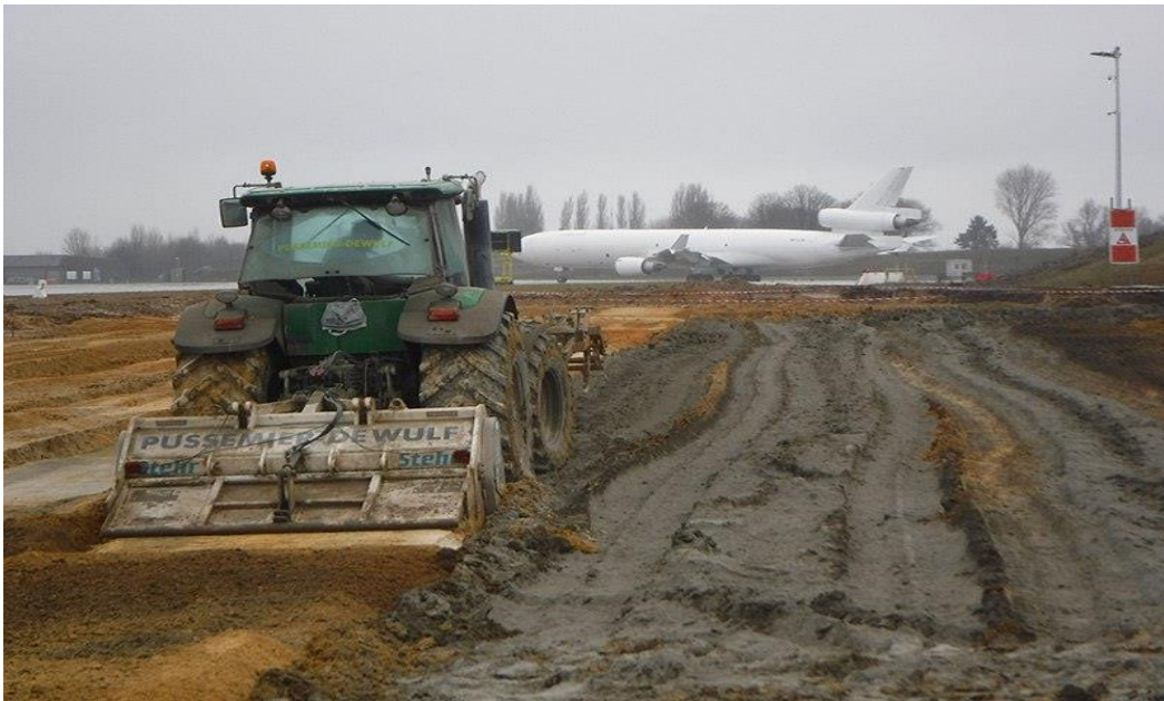
Figure I.17 : Traitement des sols au Ciment.
