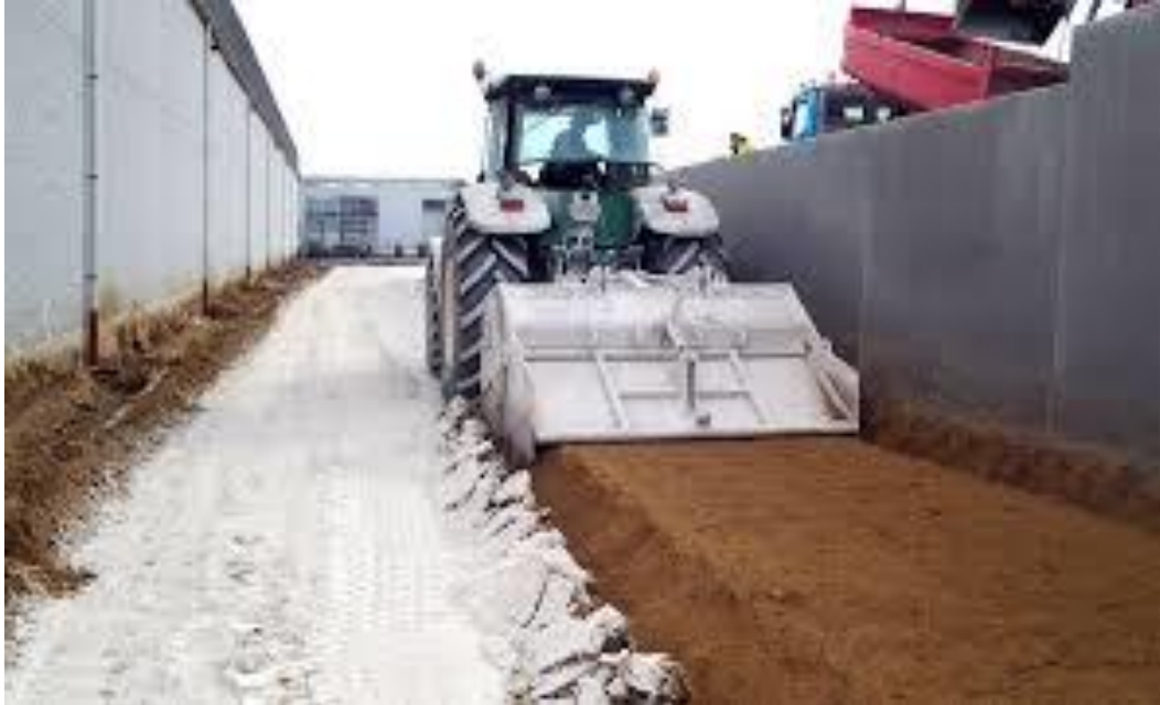
Figure I- 16 : stabiliser des sols avec de la chaux.
