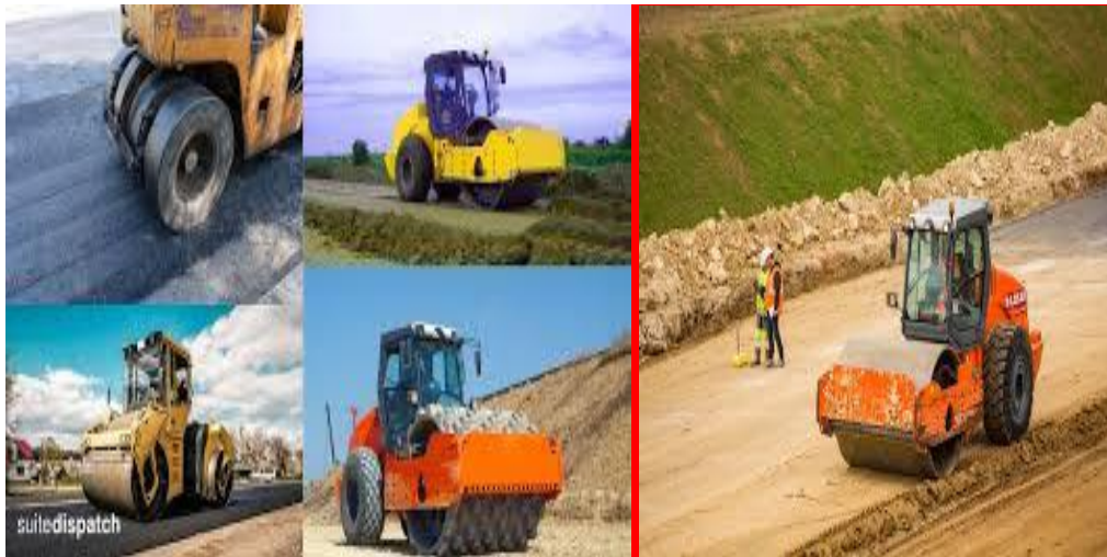
Figure I.14 : Compactage de Sol par Rouleau de Route.
