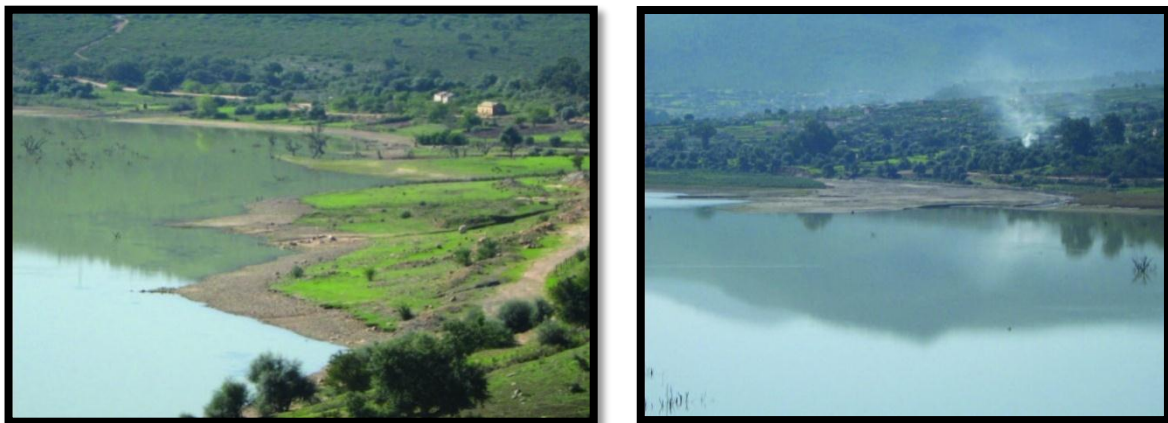
Figure V.12 Dépôts de vase dans le barrage sur la rive gauche (photo à gauche) et dépôts de vase à l'entrée de l'Oued Bougous au barrage (photo à droite) (Tourki, 2010)
