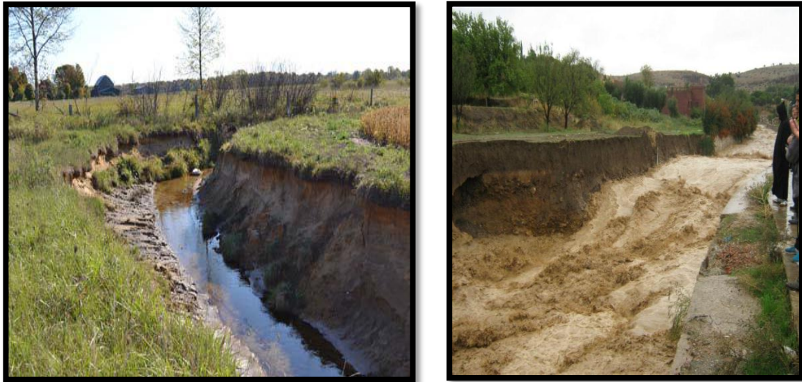
Figure V.11 Erosion des berges résulte du sapement et de l'affouillement des berges des cours d'eau naturels et des canaux de drainage.
