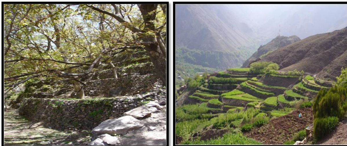
Figure VII.1 Une vue de versants aménagés par des terrasses soutenues par a-des talus et par b-des murs en pierre.
