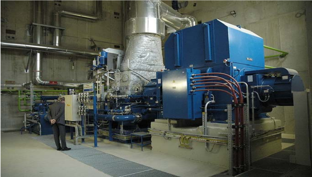
Figure 1.14 : Turbine à vapeur à biomasse de 5 MW de puissance électrique. Entreprise Blohm et Voss, Allemagne
