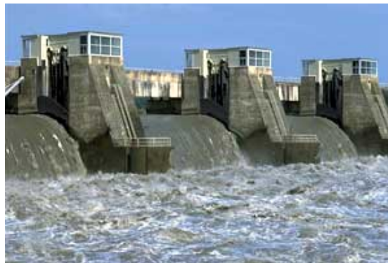
Figure 1.7 : Barrage de Rochemaure sur le Rhône © M. Morceau/Médiathèque EDF
