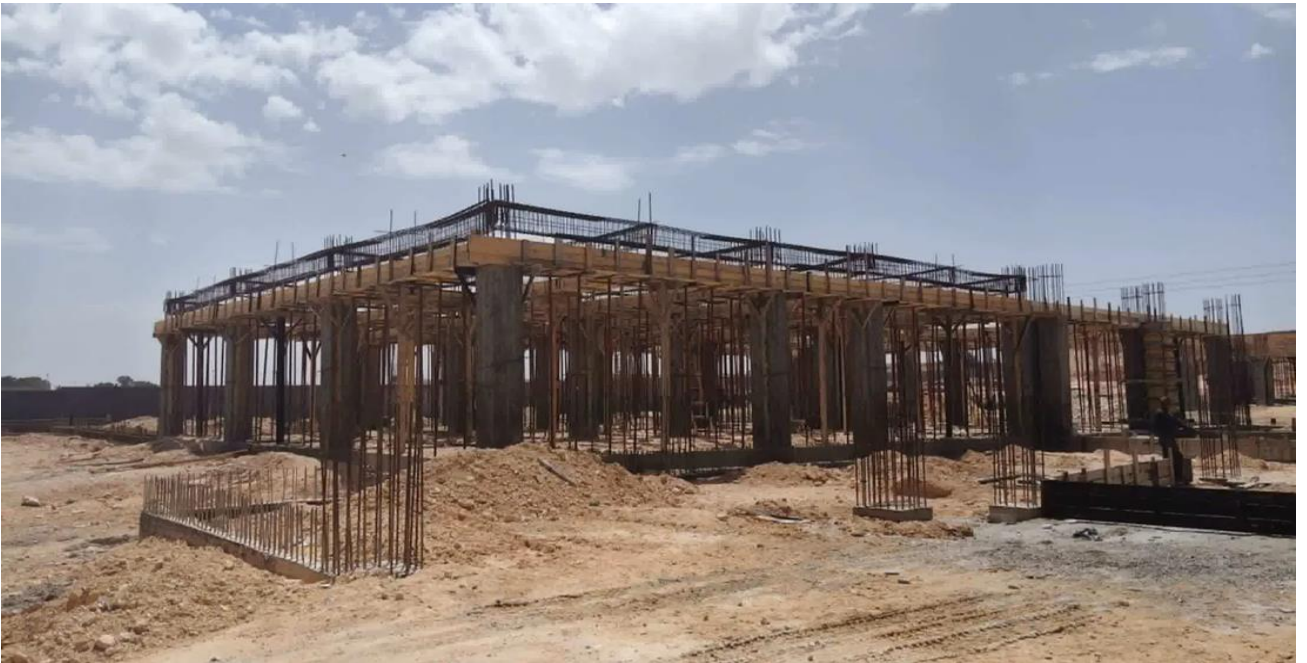
الصورة رقم 12 : للهيكل الخرساني المسلح و مرحلة تركيب القالب للسقف ( 2026/05/13 )
