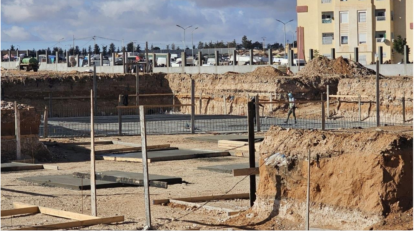
الصورة رقم 07 : زيارة ميدانية في مرحلة صب خرسانة النظافة ( 2025/12/04 )
