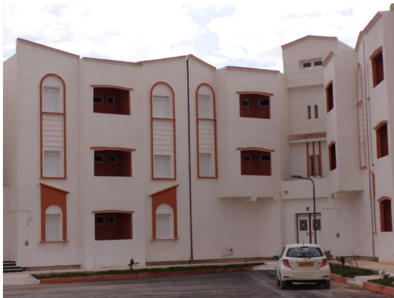
Figure I.1 : Projet des 80 logements de HPE à Djelfa (vue d'un bâtiment). [7]
