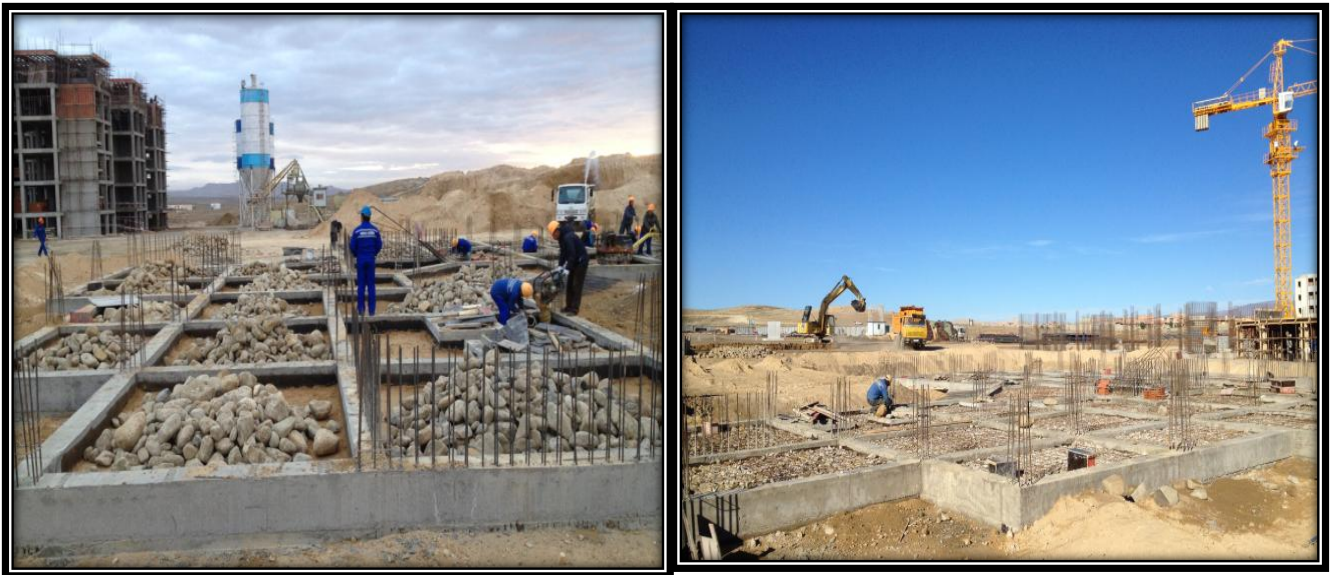
Figure III-6- La construction des remblais
