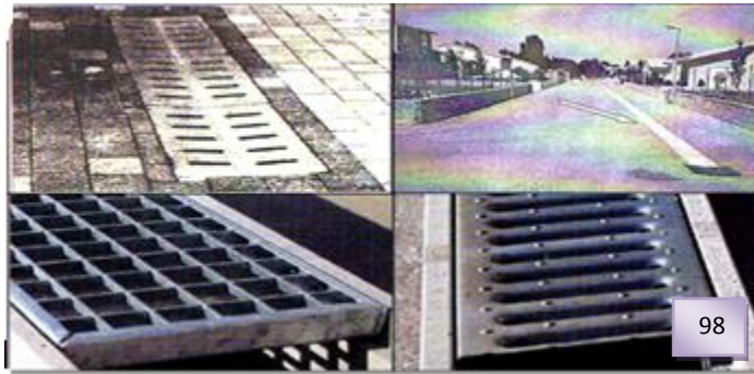
صورة رقم ( 98 ) :شبكة تصريف مياه الامطار
