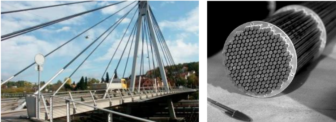
Figure I. 12 Câbles de suspension : Pont de Stork, Winterthur, Suisse [5]
