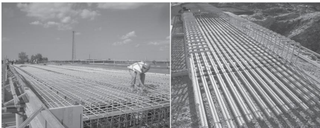
Figure I. 11 Renforcement des structures par barres en CRF : a) Tablier de pont, Canada; b) pisciculture entrée en mer, Portugal [28].
