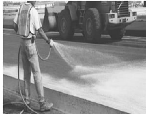
Figure 2.17 : Pulvérisation du produit De cure à la surface du béton [86].
