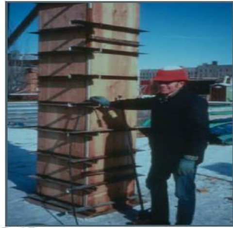
Figure 2.19 : Maintien des coffrages en Place [86].
