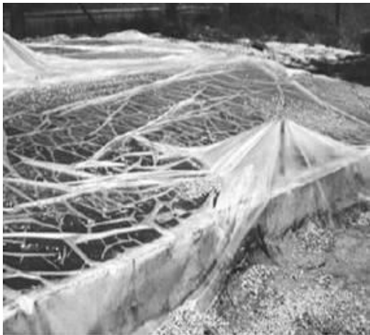
Figure 2.18 : Usage d'un polyane recouvrant La surface du béton [86].
