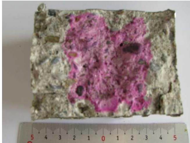
Figure 3.19 : Profondeur de carbonatation par la phénolphtaléine [62].
