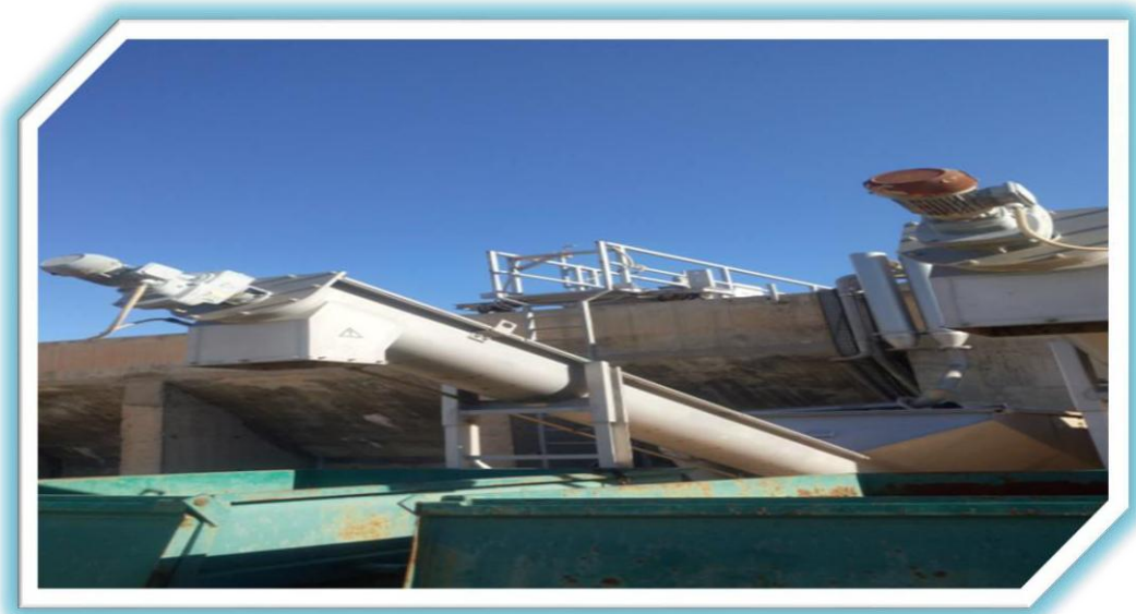
Fig.II.4 : Mécanisme de l'extraction du sable et graisse[59]
