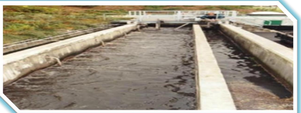
Figure I.3: Schéma d'un dessableur[36].
