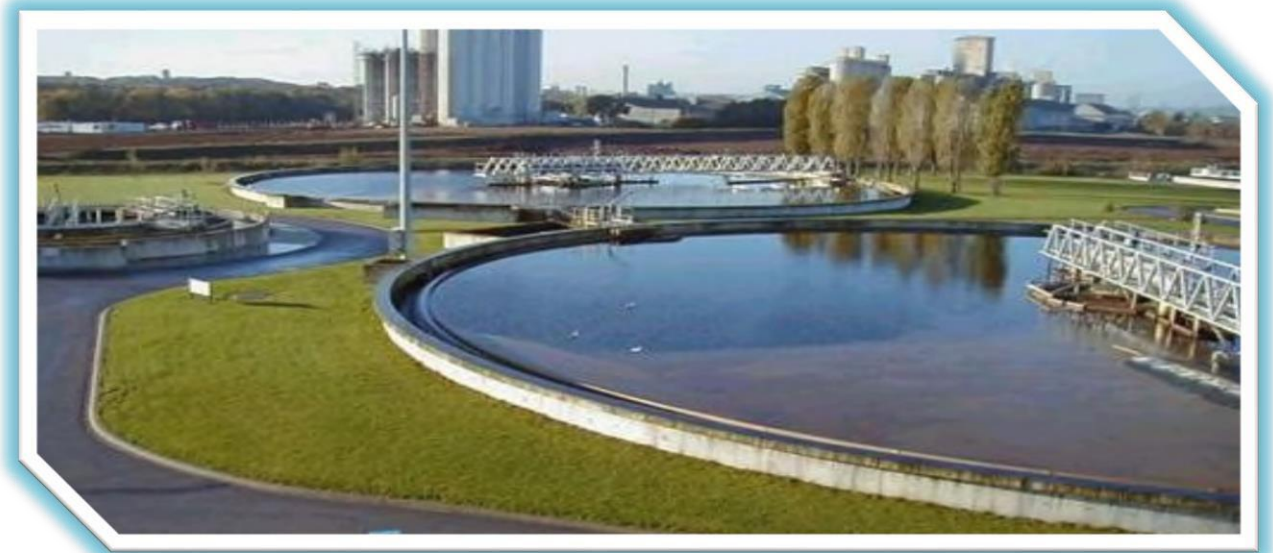
Figure I.10: décanteur secondaire «clarificateur»
