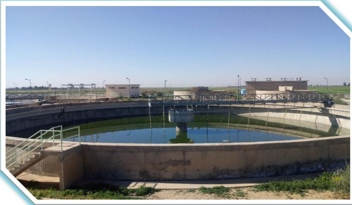
Fig.II.9. Décanteur secondaire[59]
