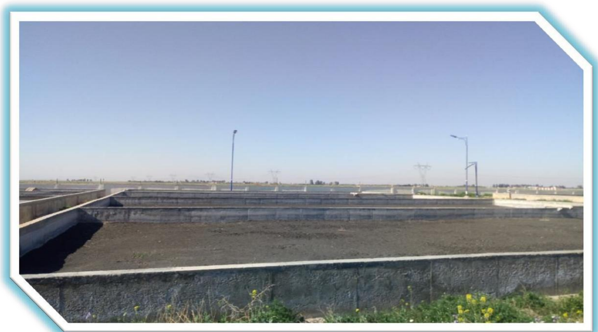
Fig.II.11.Les lits de séchage[59]
