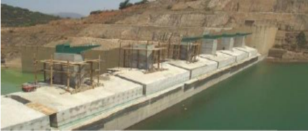
Figure I.8 Méthode de surélévation des barrages.
