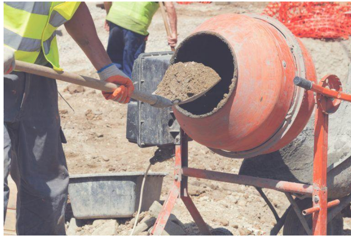
Figure I.6 : Exemple d'une fabrication des mortiers mécanique. [26]
