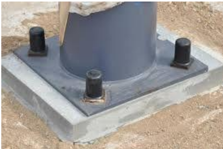
Figure I.11 : Mortier utilisé dans les scellements et les calages [36]
