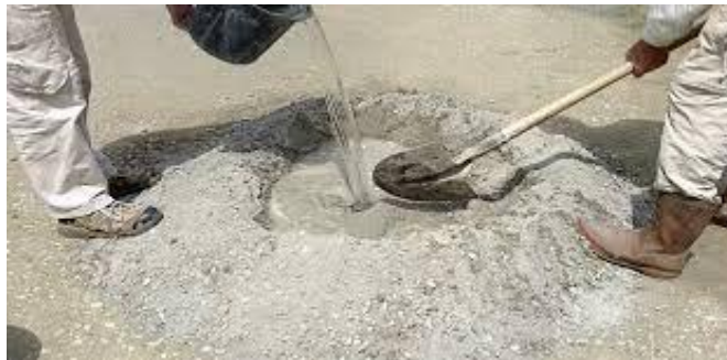
Figure I.5 : Exemple d'une fabrication des mortiers à la main. [25]
