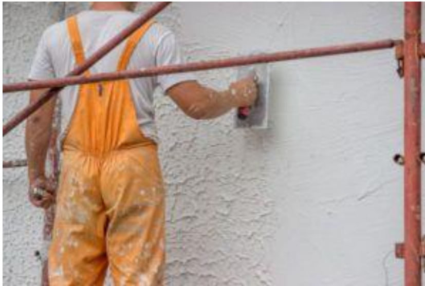
Figure I.9 : Mortier utilisé dans les enduits [33]
