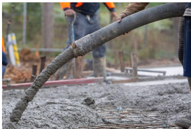
Figure I.1: coulage du béton [5].
