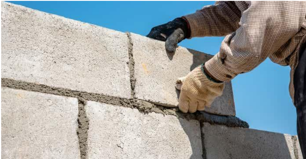
Figure I.8 : Mortier utilisé dans le hourdage de maçonnerie [32]
