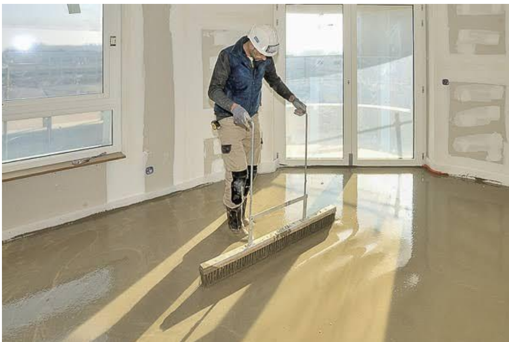
Figure I.10 : Application d'une chape de sol [34]
