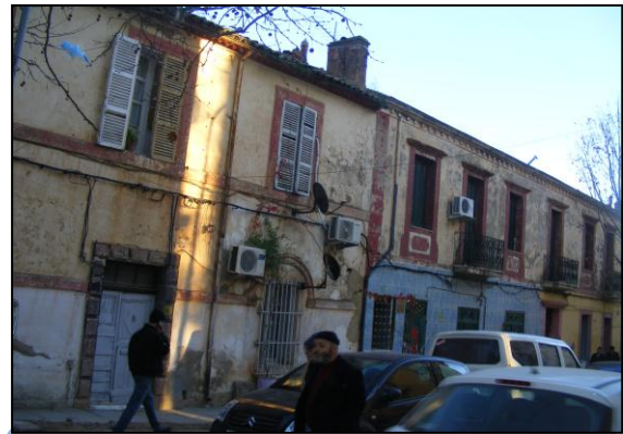
صورة رقم (40): الواجهة العمرانية الحالية 2
