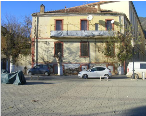
صورة رقم (37): سقف لمبنى نمط تقليدي
