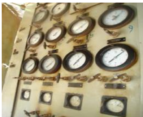
Fig I.12 Tableau des manomètres
