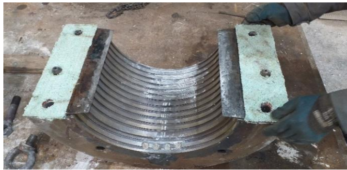
Figure IV.45: Mise en place des plaques de klingerite.
