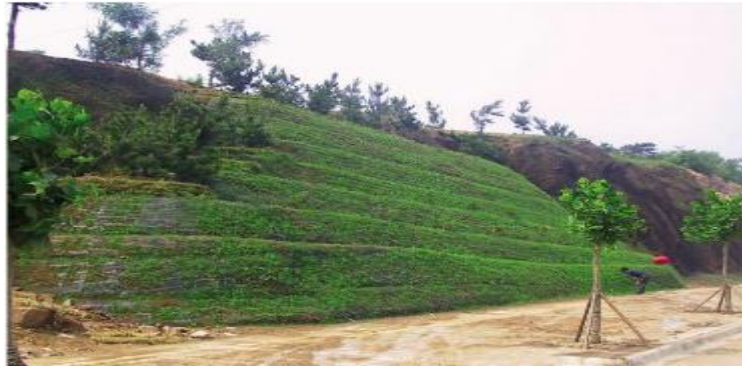
Figure I.26. L'implantation des plantes dans un talus.
