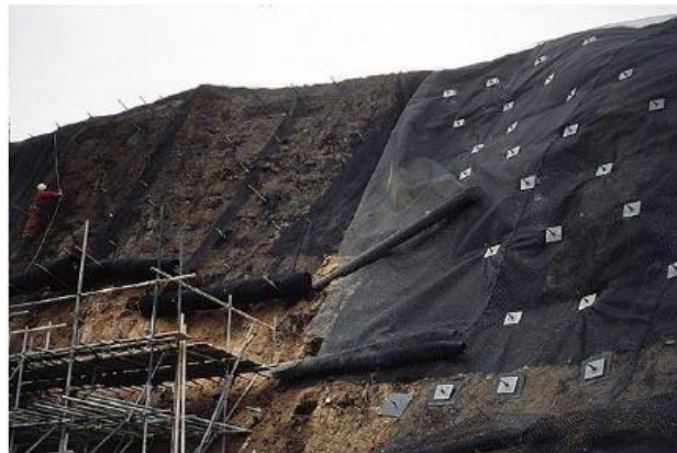
Figure I.31. Un versant stabilisé par clouage.
