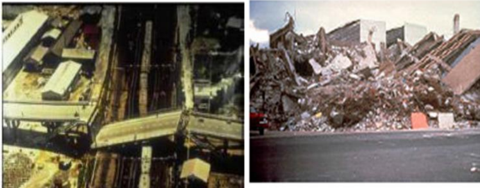
Figure (II-1) photo de séisme Northridge (Californie, 1994), et conséquence d'un séisme de Mexico
