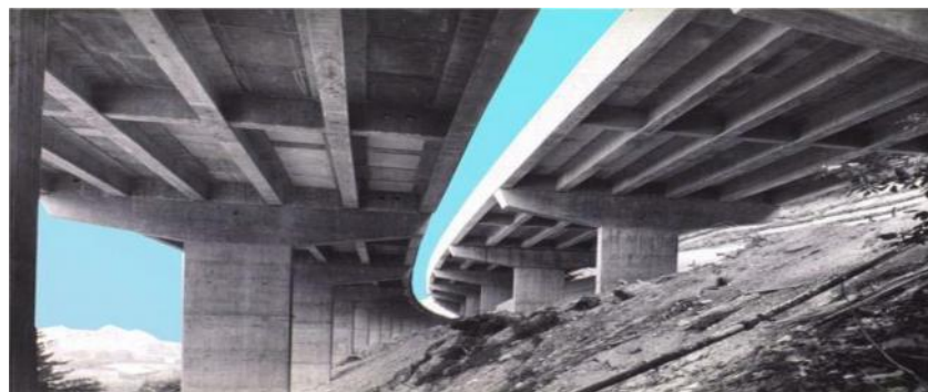
Figure (I-2) : Pont à poutre
