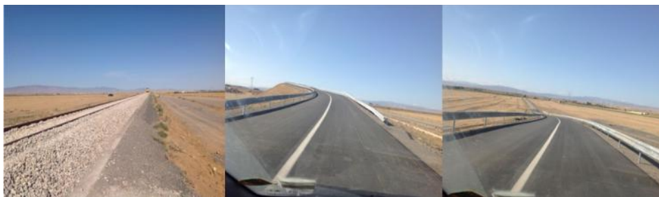
Cliche n°1: montre comme vue de la face de l'ouvrage Ain touta- M'sila
