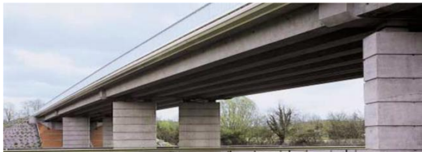
Figure (I-4) Pont dalle
