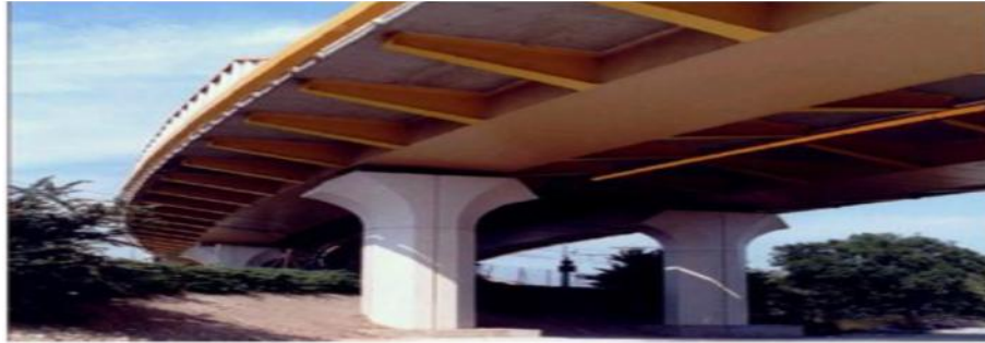
Figure (I-3) pont mixte
