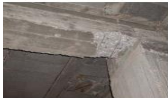
Figure II.6 : Rotule dans la poutre (Comportement recherché) [5].
