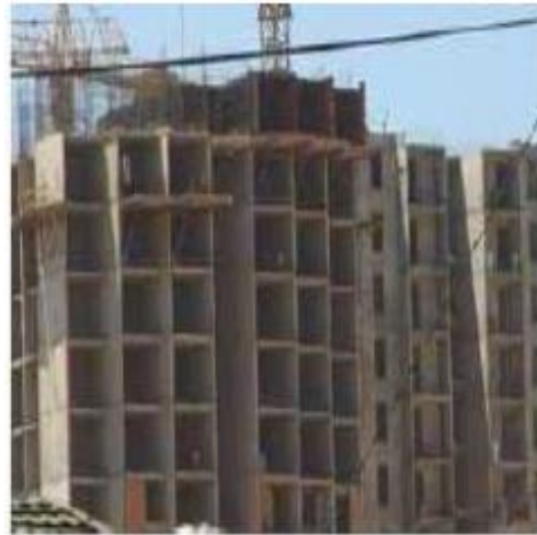
Figure II.2 : Ossature contreventée par voiles en béton armé [11].
