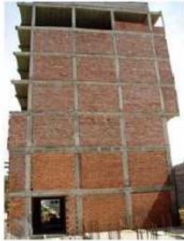
Figure II.1 : Ossature contreventée par portique auto stable [11].
