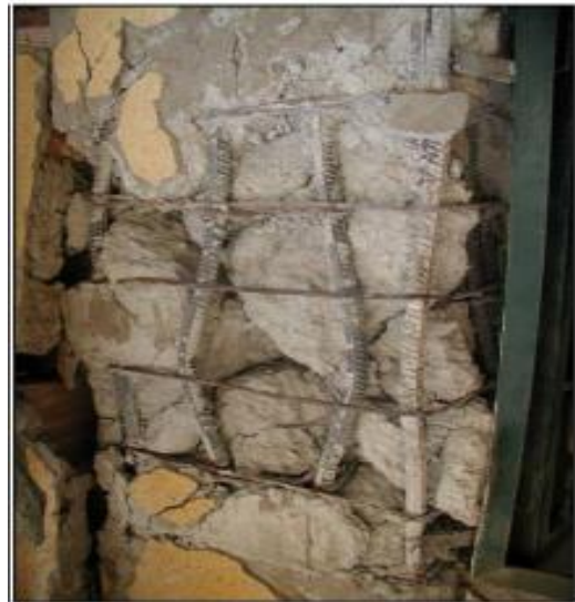
Figure II.9 : Ecrasement de béton et flambement des aciers dans les deux poteaux de la cage d'escaliers [5].
