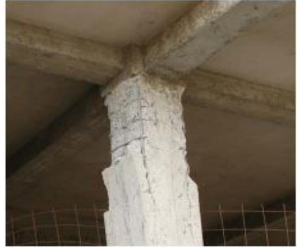
Figure II.11 : .Décollement de l'enrobage [5].
