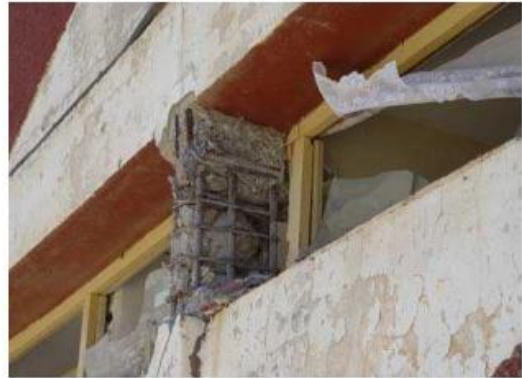
Figure II.8 : cisaillement d'un poteau court [13].
