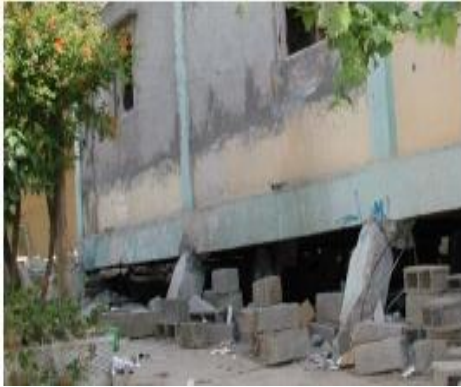
Figure II.7 : Poteaux courts dus au vide sanitaire [5].
