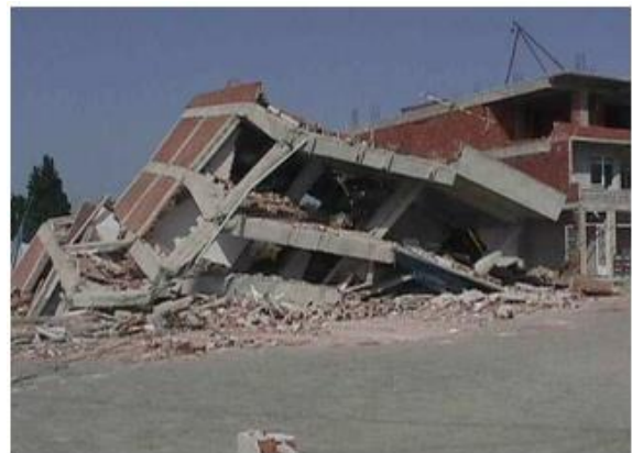
Figure II.13 : Effondrement par flexion Izmir (Turquie) en2002 [11].
