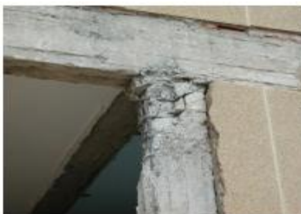
Figure II.5 : Rotule dans le poteau (comportement à éviter) [5].
