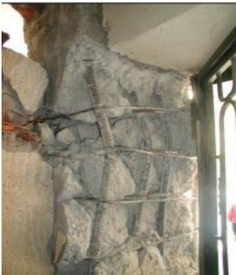
Figure II.9 : Ecrasement de béton et flambement des aciers dans les deux poteaux de la cage d'escaliers [5].
