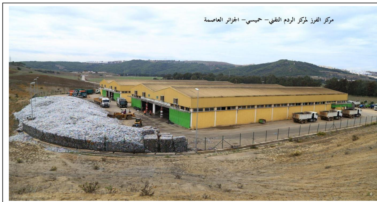
Figure 3: Centre d'enfouissement technique (CET) en Algérie
