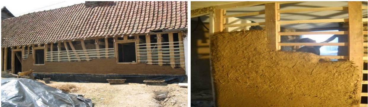
Figure I.10 : Les techniques de la construction en torchis.
