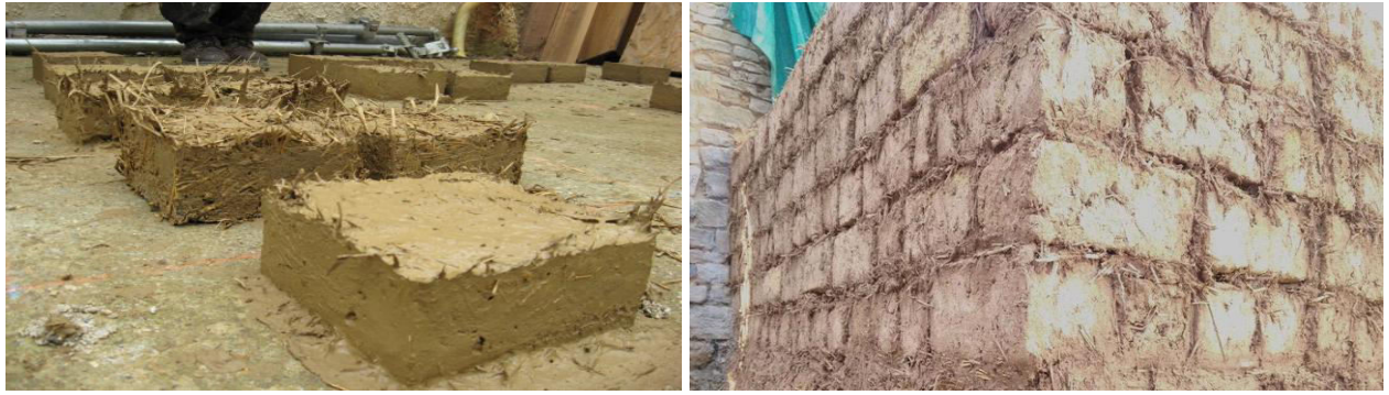
Figure I.9 : Fabrication de la terre-paille
