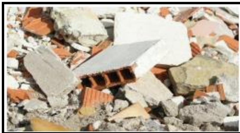
Figure II.5. Déchets de chantier.
