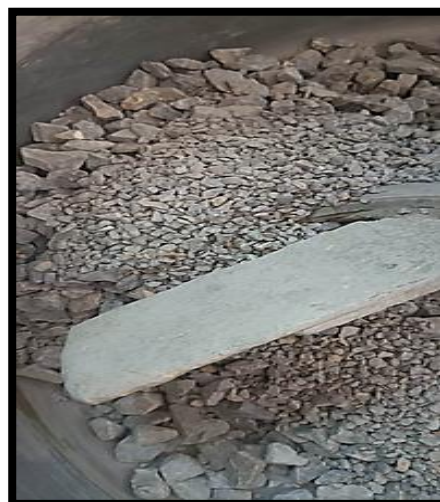
Figure III.8. Malaxage des matériaux pour l'obtention du béton.
