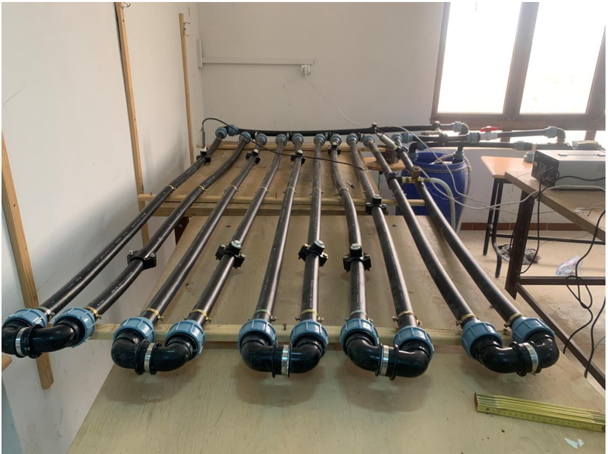
Fig. IV.7. Circuit hydraulique global
