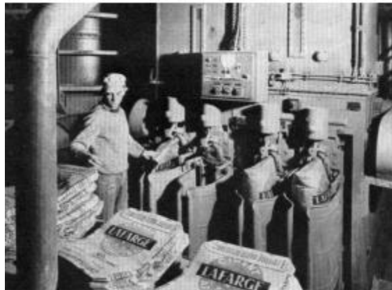
Figure I.24: remplis les sacs de ciment.
