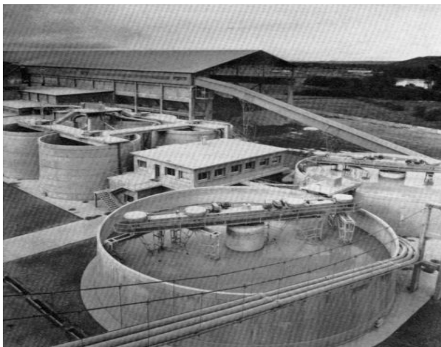
Figure I.21: bassin de délayage (alimenté d'eau).
