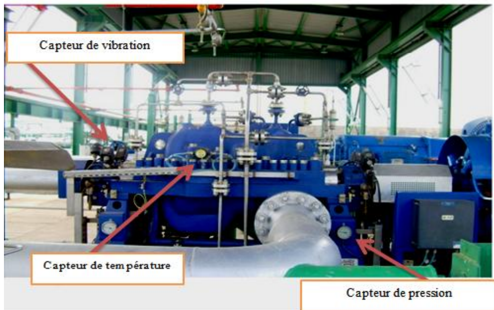
Fig. IV.14 Capteurs dans une pompe centrifuge
