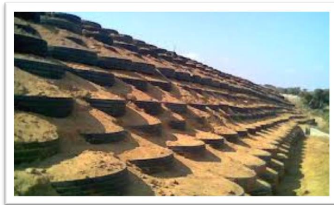
Figure (II.8) : Renforcement d'un talus de la ville de Bou-Smail
