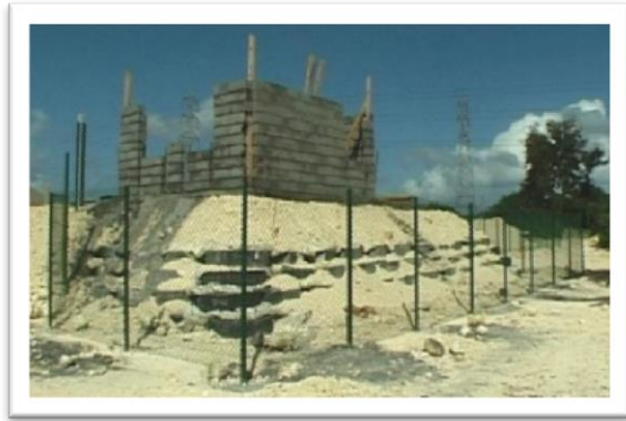
Figure(II.4) : Absorbeur d'ondes sismiques
