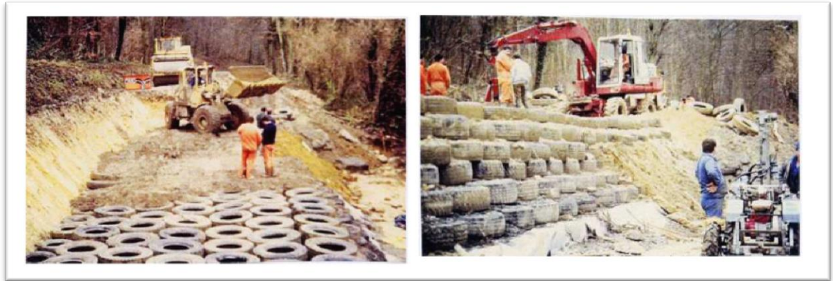
Figure(II.3) : Le chantier Cannes-Mandelieu en 1988 avec la technique de Pneusol®.
