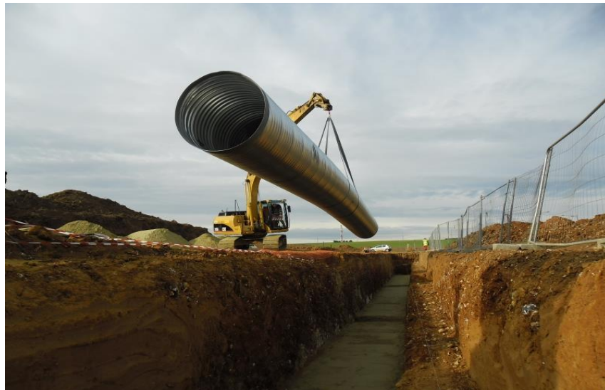
Figure VII*1 : Mise en place des conduites.
