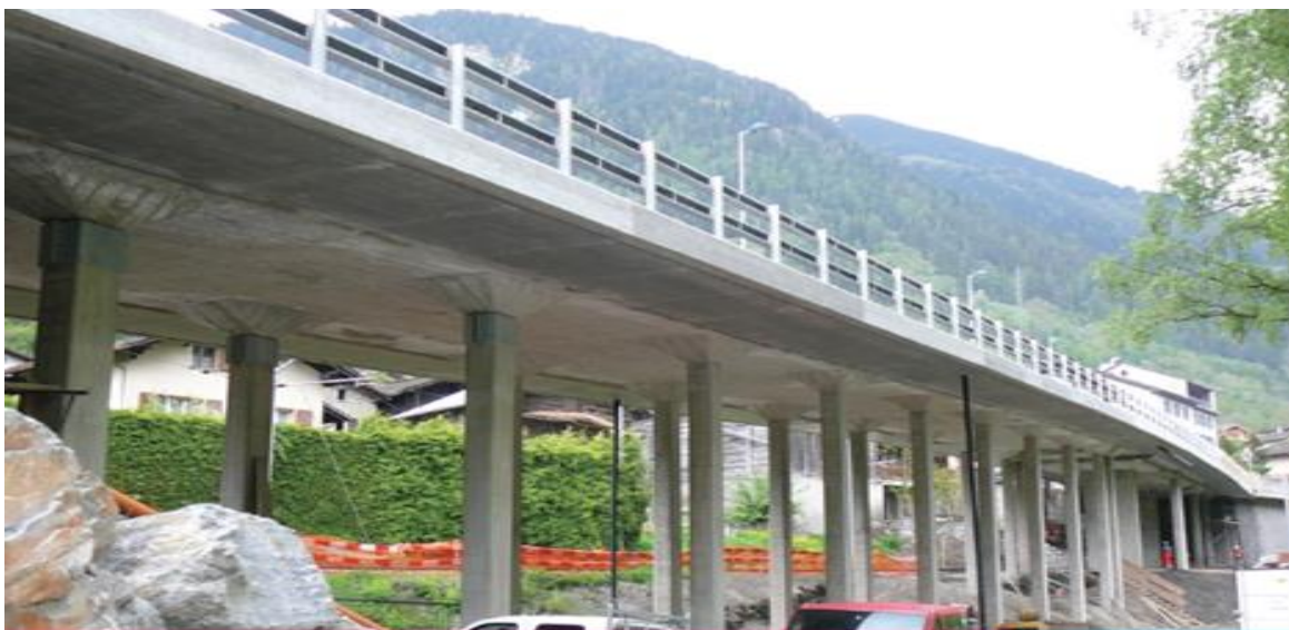
Figure II.1 : Photo représente un pont-dalle
