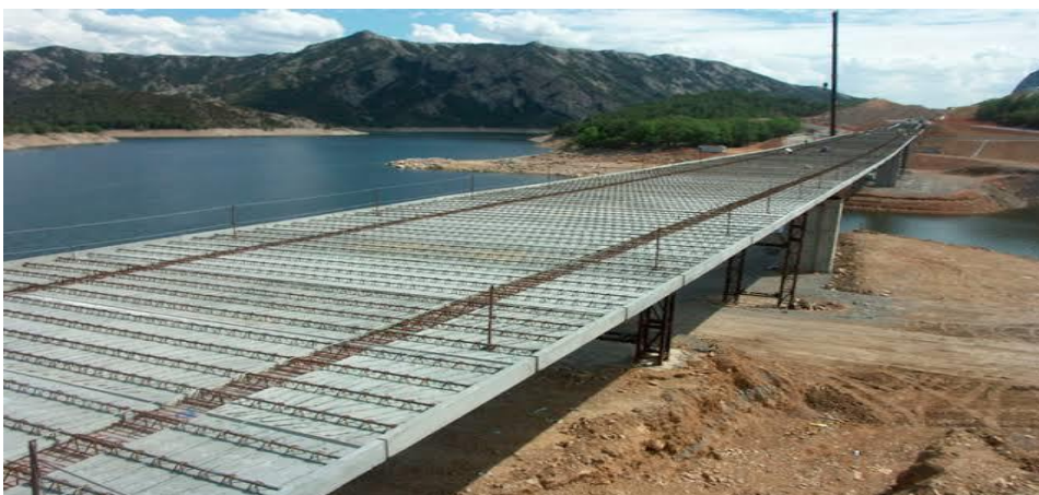
Figure III.5 : Tablier de pont en béton
