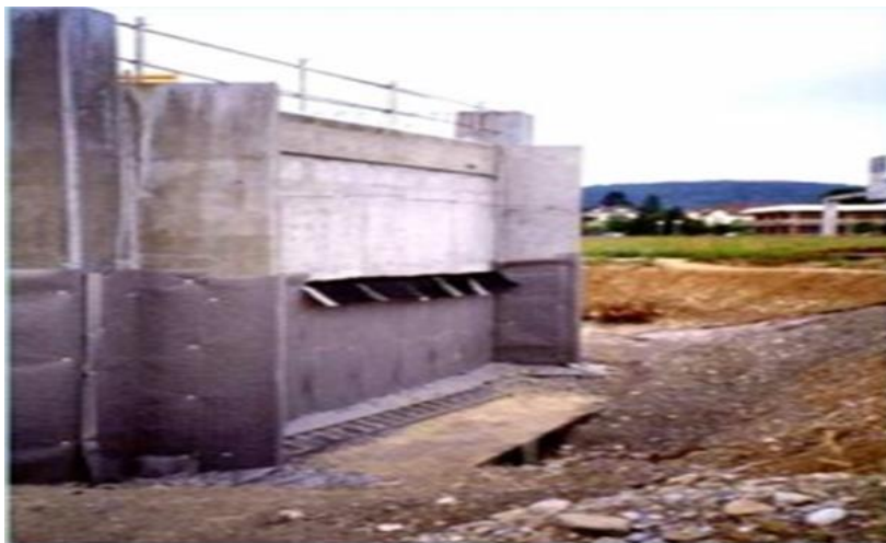
Figure II.8 : Photo représente les culées
