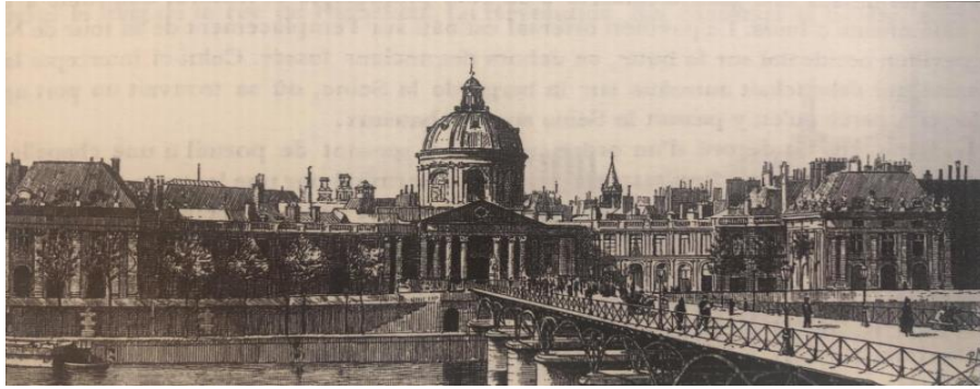
Figure I.3 : Pont métallique de paris
