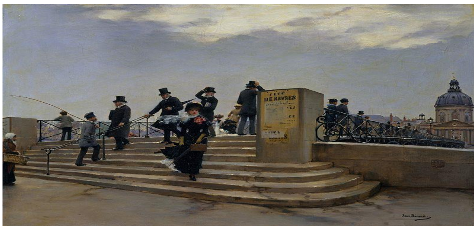
Figure I.4 : Le pont coulé par une barge
