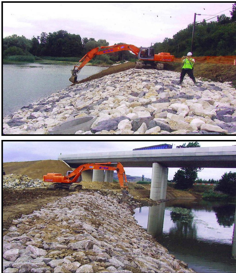
Photo n°13 : La fixation de rive par enrochement
