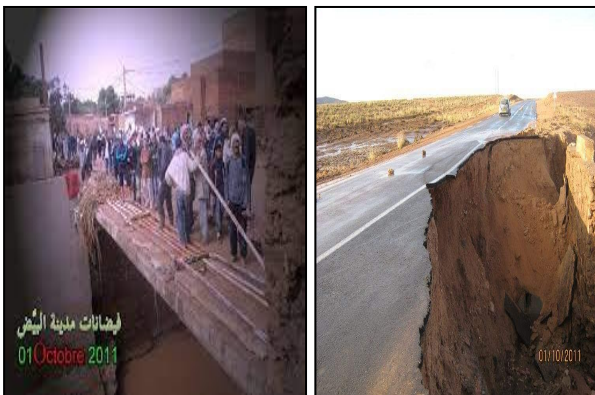
Photos n°23 : axes routiers et ponts détruit (Source : protection civile)
