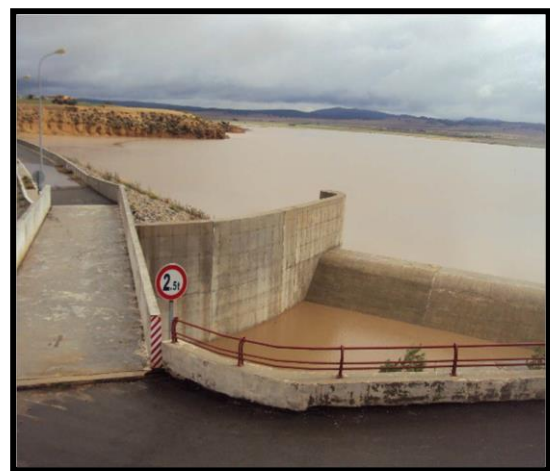
Photo n° 12 : Barrage d'écrêtement (oued MEKERRA) (Source : MRE, 2018)
