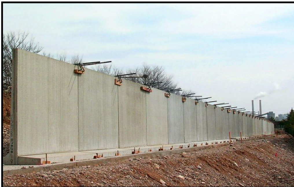
Photo n° 15 : Mur de soutènement Source : https://www.archiexpo.fr/
