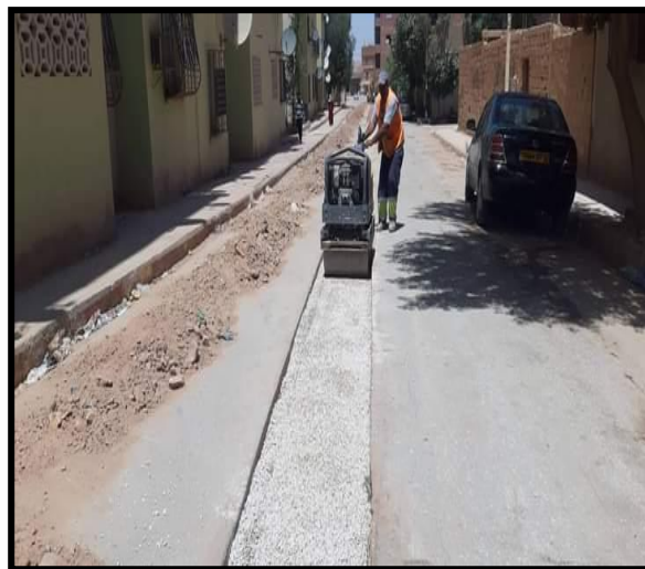
Photo n° 19 : La rénovation du réseau d'assainissement de la ville (Source : DRE,2022)
