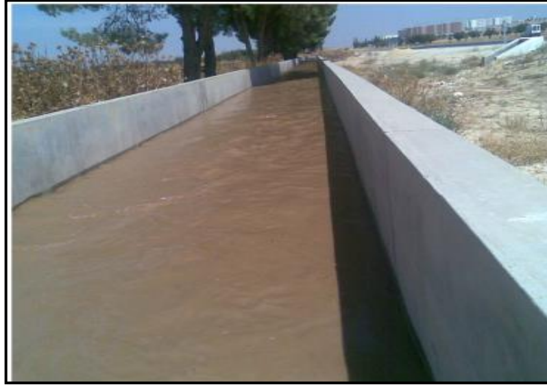
Photo n°11 : Canal de prise sur l'oued pour la dérivation d'un débit de 2,5 m 3 /s vers le barrage SARNO. (Source : MRE, 2018)
