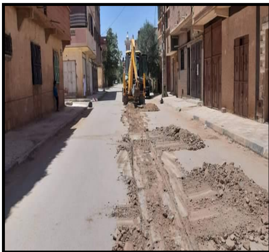
Photo n° 19 : La rénovation du réseau d'assainissement de la ville (Source : DRE,2022)
