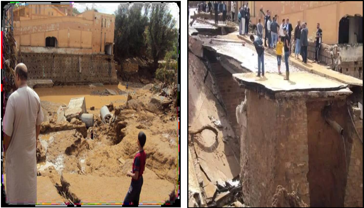
Photos n°24 : Impacts sur le réseau d'assainissement (Source : protection civile)
