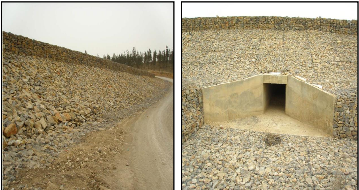
Photos n°09 : création d'ouvrages de rétention sur l'Oued MOUZZENE (Source : MRE, 2018)
