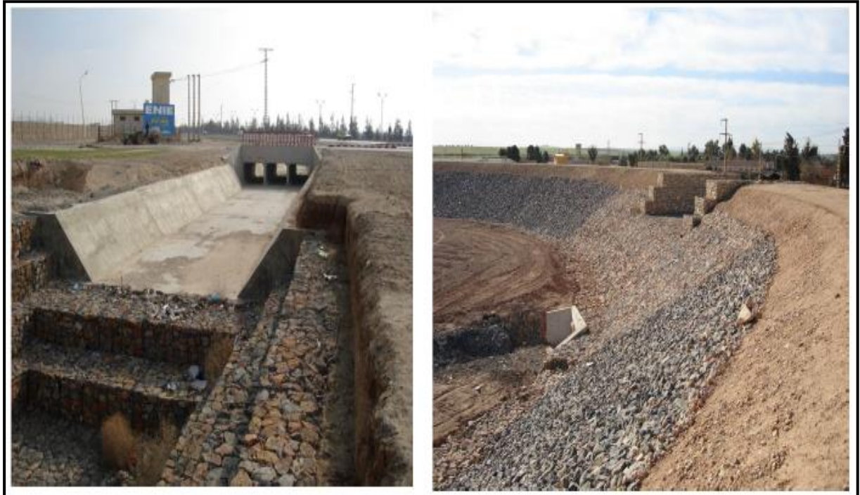
Photos n°08 : création d'ouvrages de rétention sur l'Oued MELLAH (Source : MRE, 2018)
