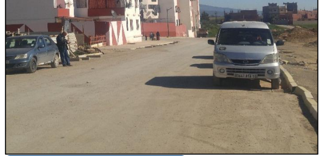
الصورة رقم (56): الطريق الرئيسي عند المدخل
