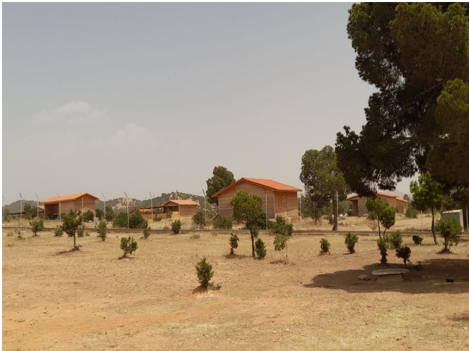
Figure 28 : Un petit pavillon d'hébergement (Bungalow) (Origine 2024)
