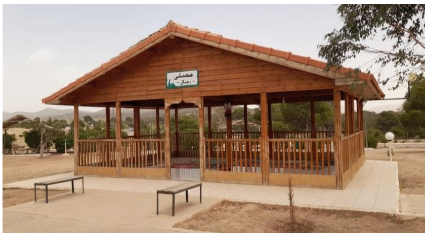
FIGURE 22 : Salle de prière au niveau de station d'étude (Origine 2024)
